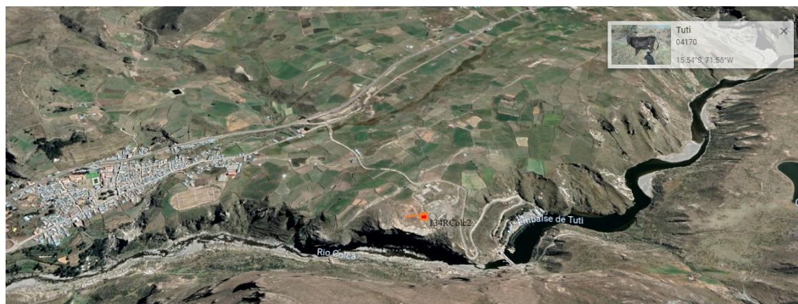
Figura 3. Bocatoma de Tuti, foto satelital. Fuente: ANA Autoridad Nacional del Agua
