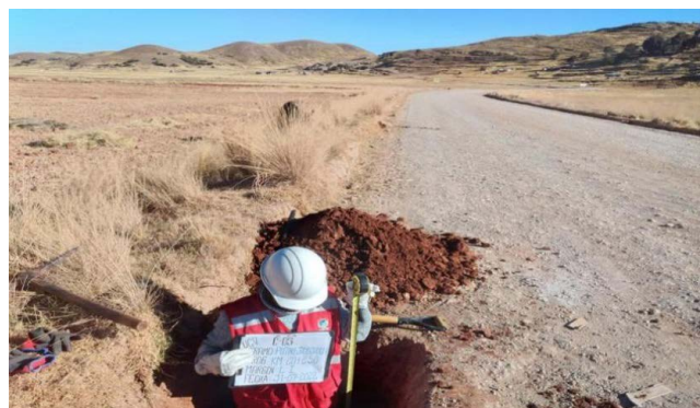
Figura 1. Extracción de muestra de calicata C-03
