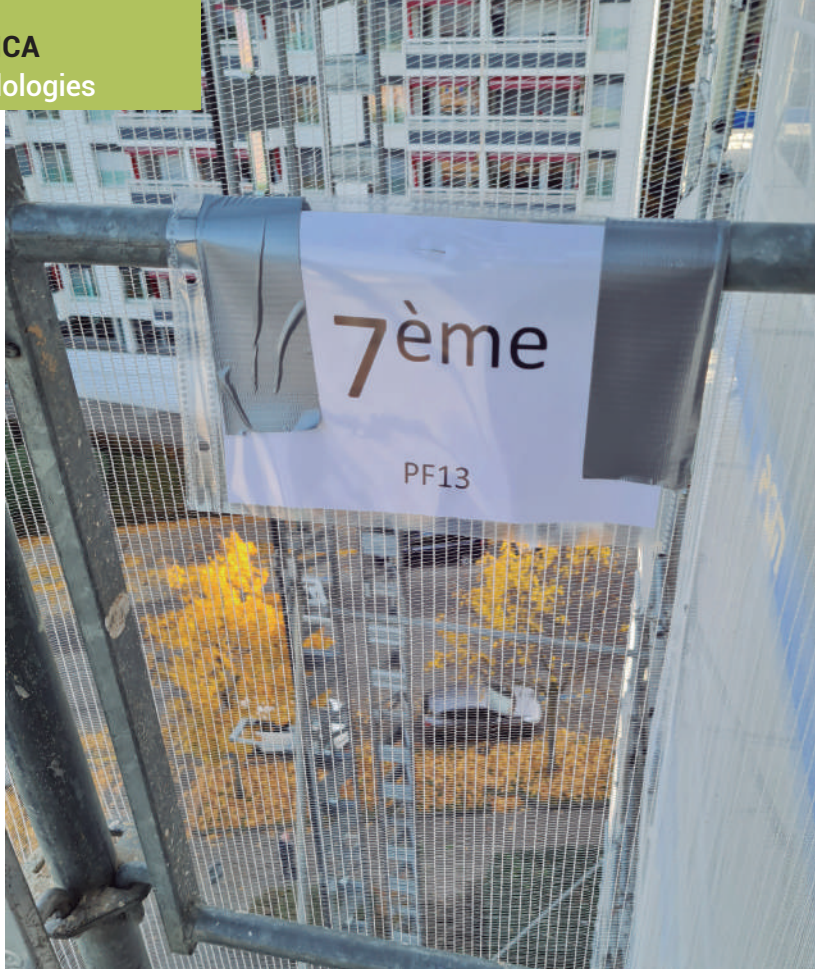
Durant el procés d'obra, indicar el número de la planta a la bastida evita pèrdues de temps
