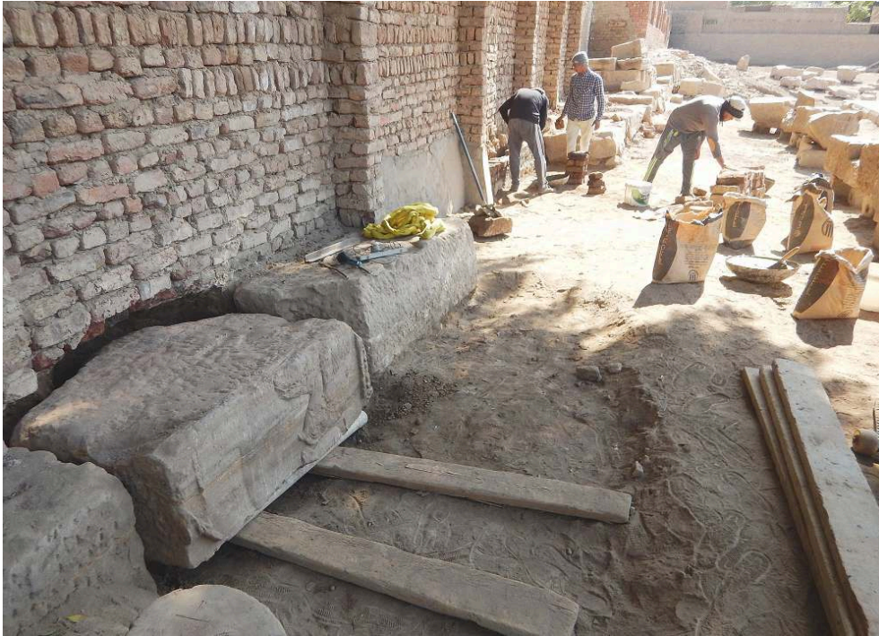
Fig. 19. Extraction du bloc 523 du mur romano-byzantin et consolidation du mur moderne (C. Thiers).
