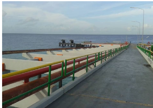
Fig.4. Imagen que muestra el puente de aproximación a la plataforma principal del muelle.
