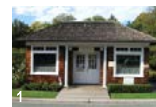
1. Existing Visitor Center
