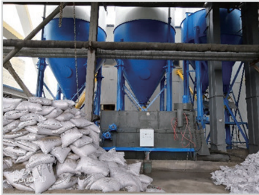
图1 地面充填搅拌站
