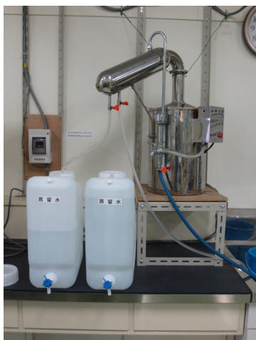
写真 2. 耐震固定されたバンステッド蒸留水製造機
