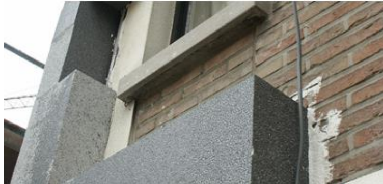
Figura 5.10. Aplicación de SATE sobre una vivienda. Fuente: Google Imágenes.
