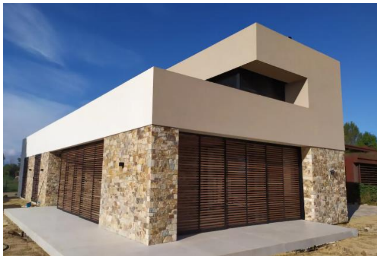
Figura 5.11. Vivienda con aplicación de SATE con acabado en dos texturas. Fuente: Google Imágenes.
