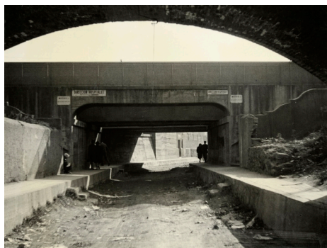
Fig 06. Pont dels ferrocarrils sobre la riera Blanca. 1964 Font: AHCB
