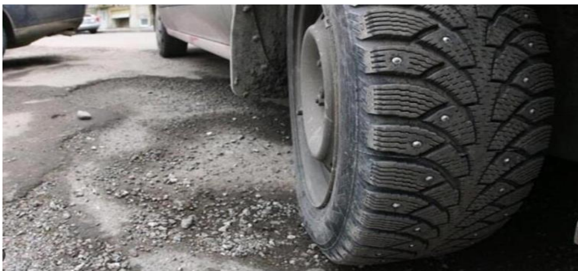
Рис. 1. Стирание верхнего слоя от шипованных шин
