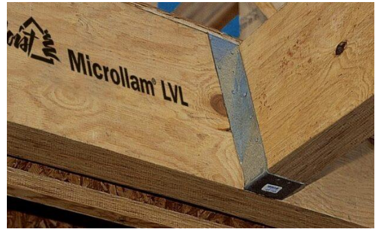
Рис. 6. Соединение балок из LVL-бруса
