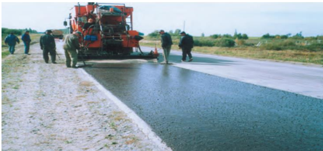
Рис. 2. Устройство защитного слоя «Сларри-Сил»
