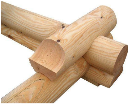
Рис. 5. Соединение оцилиндрованных бревен
