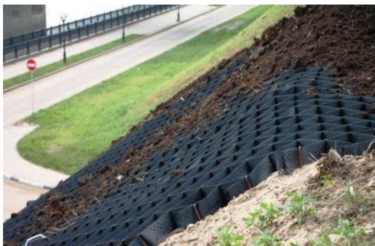
Рис. 1. Применение георешетки при возведении откосов насыпи
