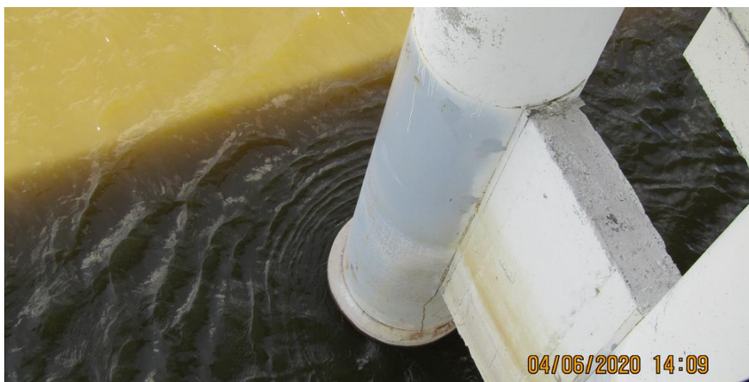
Рис. 1. Вертикальные трещины на опоре автодорожного моста
