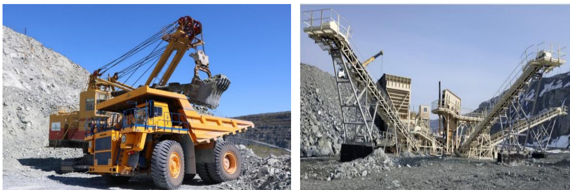
Рис. 3. Техника, используемая на Баженовском месторождении (большегрузные самосвалы, дробильно-сортировочная установка)
