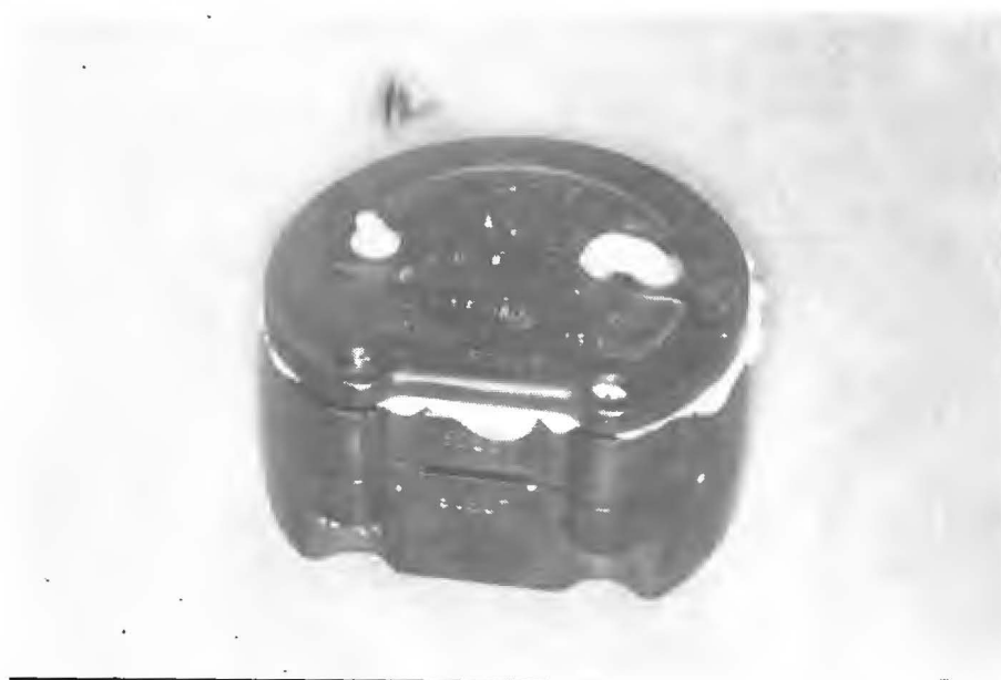
Figura 12.11. – Colocação da tampa da mufla.
