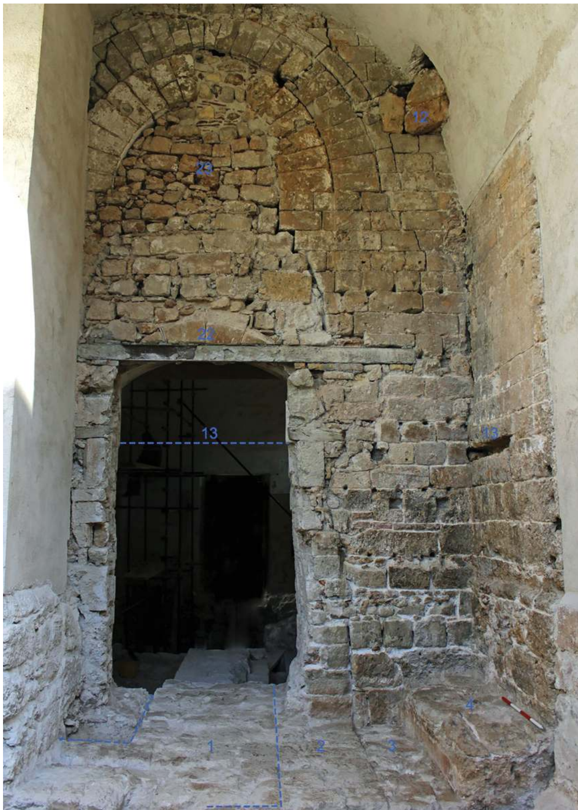
Fig. 30. Palermo, Cuba Soprana. Frente sur. Espacio 5. Muro de sillería perteneciente a la fachada del edificio fundacional (1). El nº 2 y 3 corresponden a la ampliación árabe de la fase II. El 4 es un banco del siglo XVI, retallado en la fábrica de sillería de la fase II. El 23 es la puerta de acceso al pabellón normando (Fase III) y el 13 indica la cota a la que se encontraba el pavimento de la plataforma (foto LAAC, EEA, CSIC).
