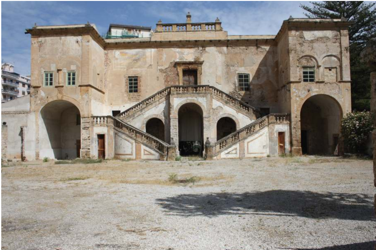
Fig.3. Villa Napoli. Prospetto sud
