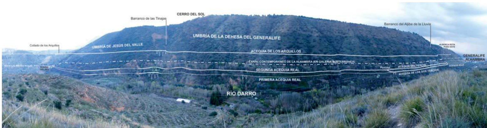
Fig. 3. Vista panorámica de la Umbría del Generalife, con el desarrollo de las canalizaciones hidráulicas que la recorren o la han recorrido.
