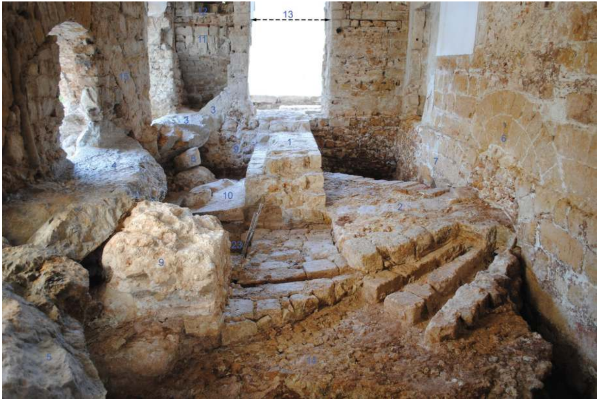
Fig. 11. Palermo, Cuba Soprana. Espacio 6. Vista desde el norte. A la derecha se aprecia la plataforma inclinada (2) que protege los tubos metálicos que pasaban por debajo de la fachada fundacional (1) y alimentaban el estanque (10), en cuyo interior hay tres grandes rocas (3,4 y 5) que fueron removidas y apuntaladas con piedras menores (8). Debido a problemas de estabilidad de fachada fundacional (1) fue necesario reforzarla con una obra de mampostería y cal (9). En la fase II el edificio se amplió sobre la alberca y para ello se construyó una nueva fachada (15) y cubrir las grandes rocas con tres bóvedas (11). El nº 13 señala la cota a la que estaba el suelo de la plataforma sobre la que se alzaba el pabellón. Tanto el muro de la derecha (7) como el arco de descarga (6) son de la fase normanda. El nº 23 corresponde a la entrada del pozo hidráulico de época moderna (foto LAAC, EEA, CSIC).
