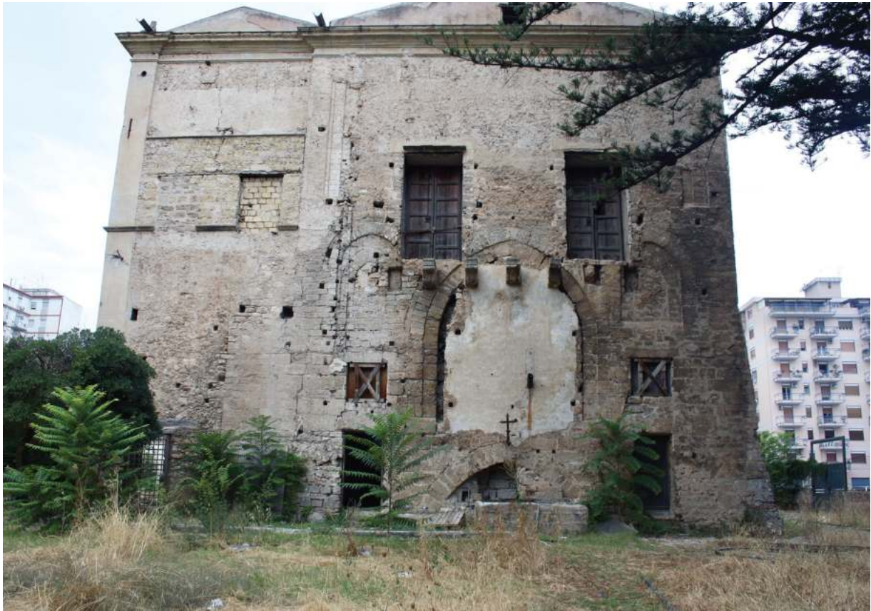
Fig.4. Villa Napoli. Prospetto Est
