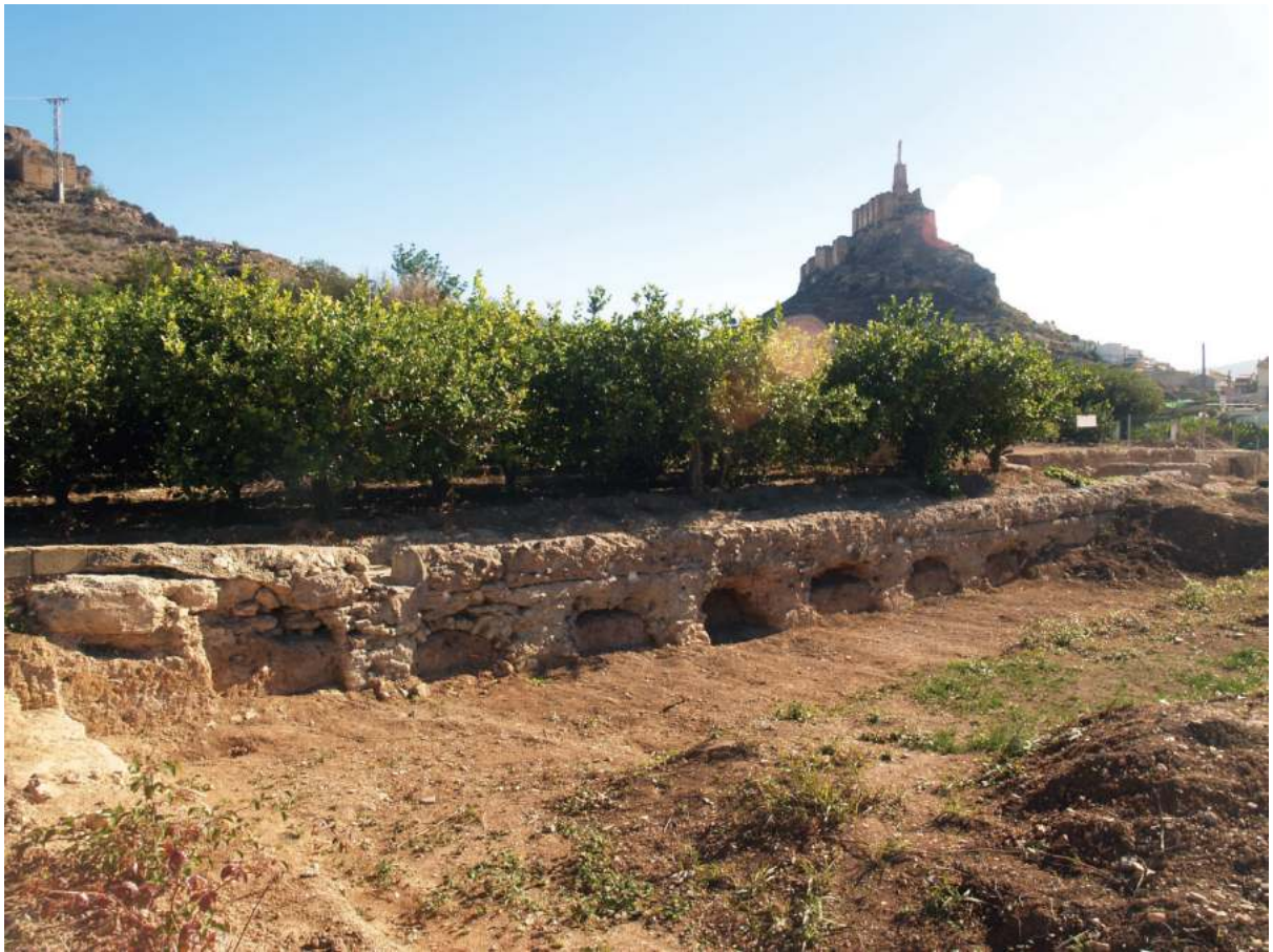
Fig. 22. Parcela II. Tramo norte-sur del acueducto. Al fondo, el Castillo de Monteagudo
