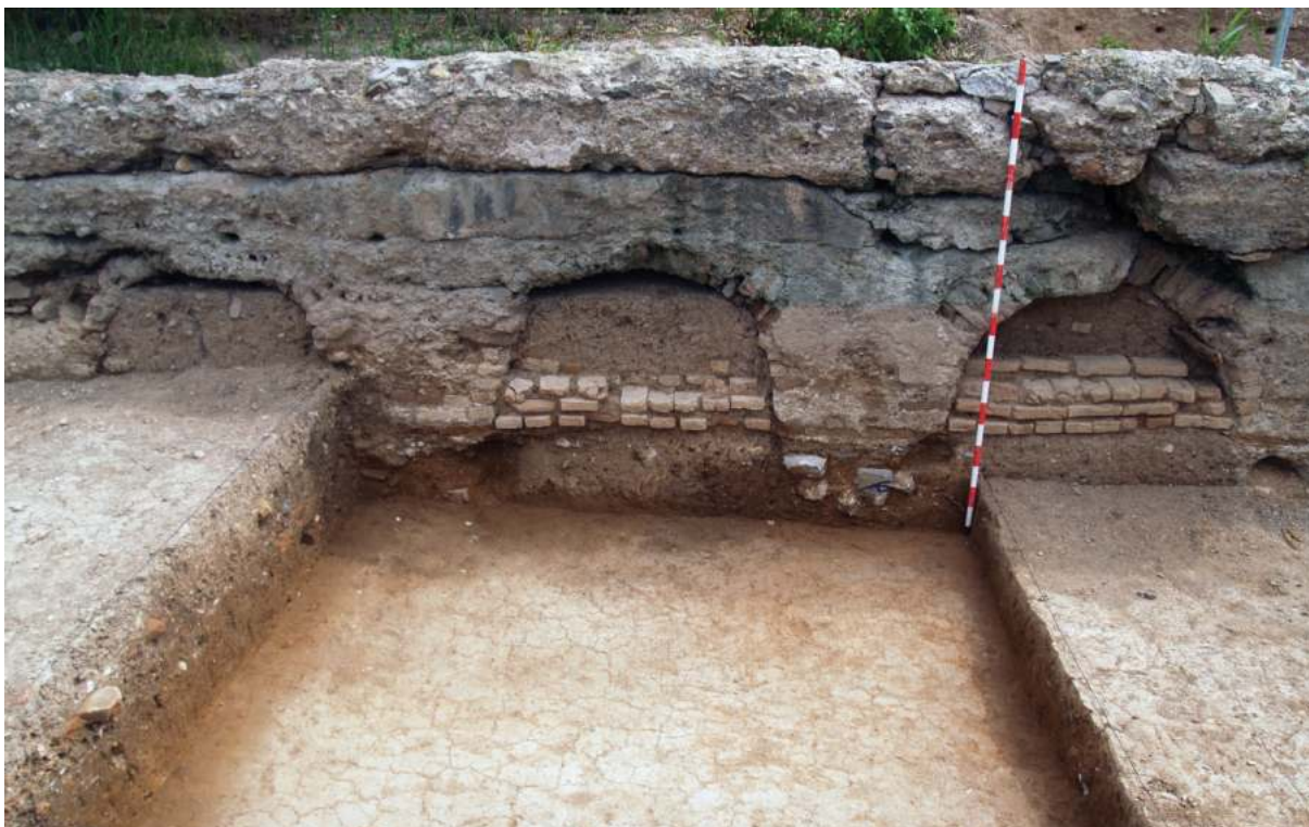
.Fig. 23. Parcela II. Sondeo junto al acueducto. Apréciense las obras de ladrillo con que se reforzó la arquería.
