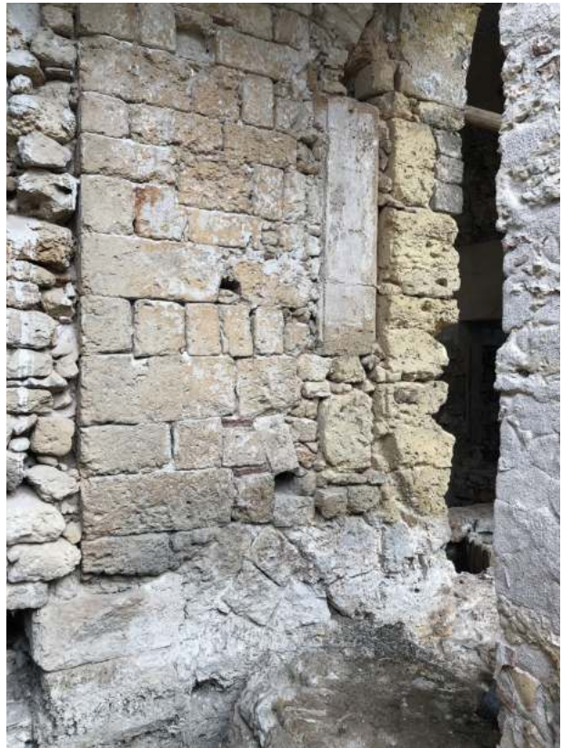
Fig.3a. Villa Napoli. Prospetto sud, particolare
