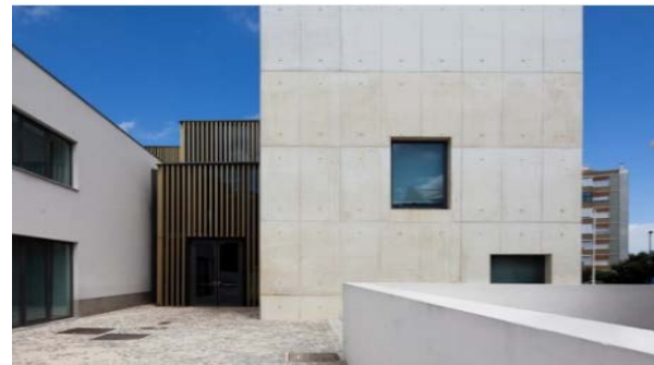
Fig. 37.4 - ESVF - Circulação exterior, ligação do bloco de entrada com o bloco adjacente com cota superior.
