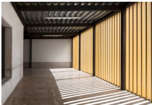
Fig. 37.5 - ESVF - Galeria Exterior.
