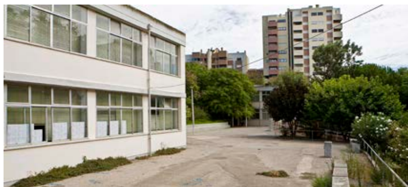
Figura 35 – ESVF, Espaços exteriores antes da intervenção da Parque Escolar. Fonte: obtido do Portal do Parque Escolar: https://www.parque-escolar.pt/pt/escola/088
