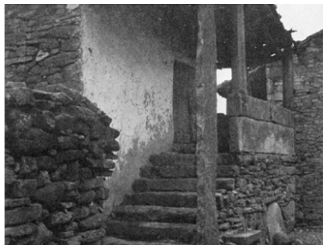
Figura 7 - Escadaria exterior em Malhada Sorda Fonte: (Amaral et al., 1988)
