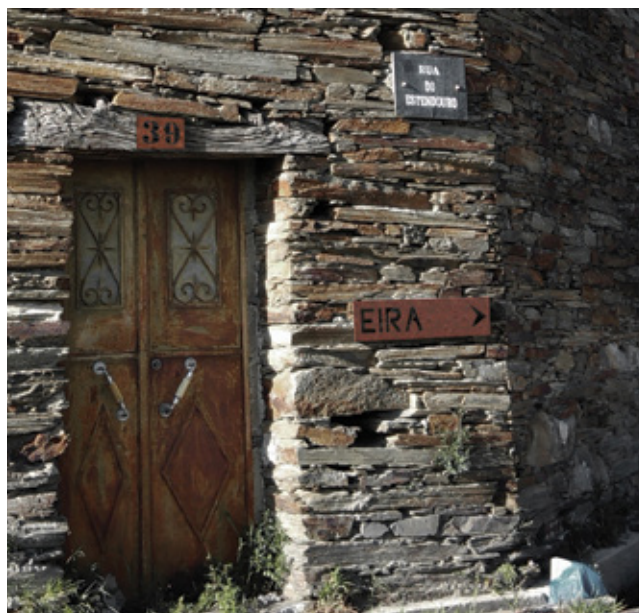
Figura 109 - Exemplo de aplicação de placas de sinalização e números de polícia Fonte: o autor
