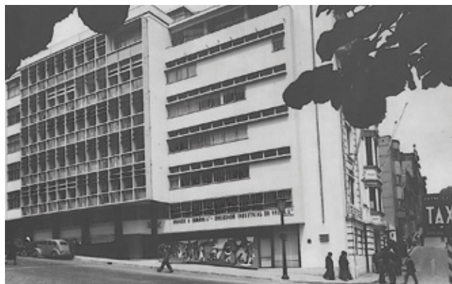
Figura 07: Fachada sul do edifício Vouga/ Soares & Irmãos. Estudo de relação entre as entradas, as divisões e circulações interiores, 2018
