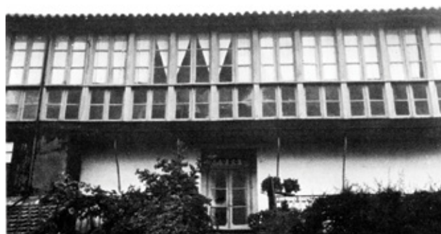
Figura 9 - Varandas envidraçadas em Fonte Arcada e Moimenta, respetivamente Fonte: (Amaral et al., 1988)
