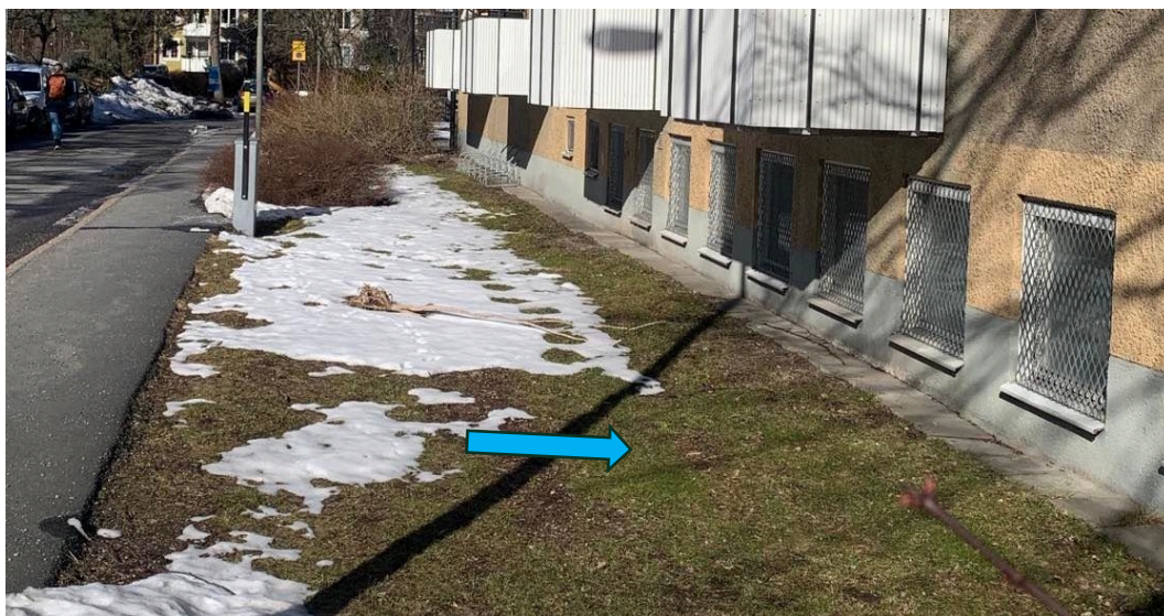
Figur 11. Gräsytan lutar i dagsläget bitvis in mot fasaden. Då området är smalt och intill en väg är det inte troligt att de boende nyttjar ytan. Blå pil visar lutning (Foto: Sandra Andersson 2023).
