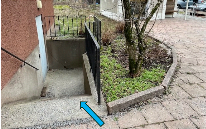
Figur 21. En av källarnedgångarna på fastigheten, nedgången saknar tak och förhöjd kant vilket gör att källarnedgången är oskyddad vid kraftiga regn. Blå pil visar lutning (Foto: Frida Helander 2023).
