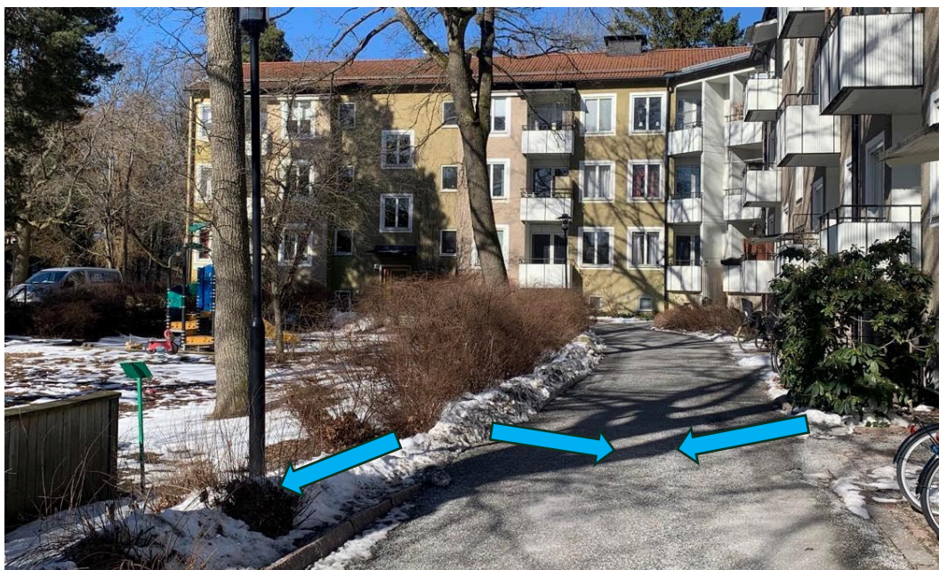
Figur 19. Innergården vid den större byggnaden. Här finns en stor naturlig svacka som passar bra för att fördröja stora mängder vatten, men kantsten och växtbäddar hindrar vatten från att rinna ned från fasadsidan. Blå pilar visar lutning (Foto: Sandra Andersson 2023).
