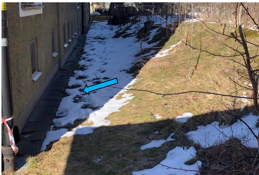
Figur 13. Fasad på baksida av stora byggnaden. En höjdrygg med berg i dagen skapar lutning in mot fasaden. Blå pil visar lutning (Foto: Sandra Andersson 2023).
