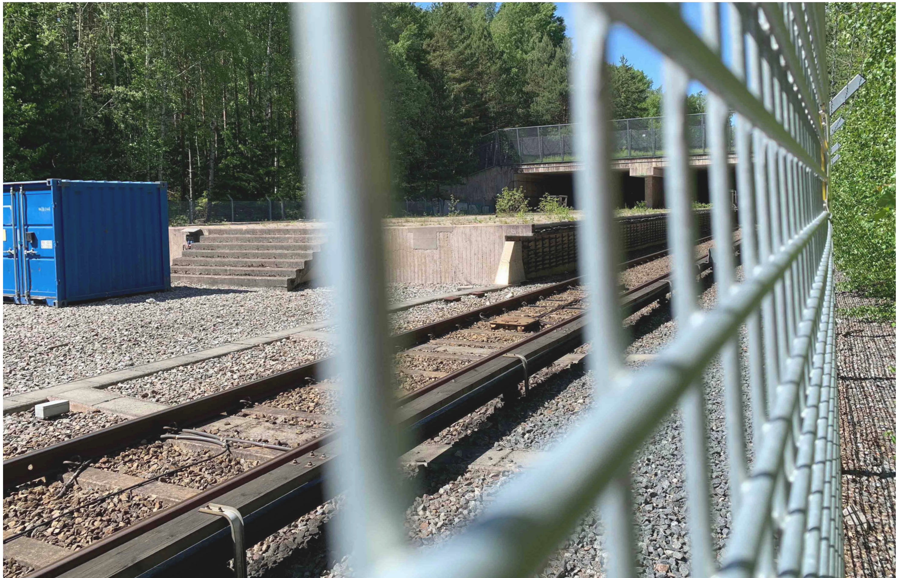
Fig 57. Tunnelbanestationen bakom stängslet som löper längs spåren. Utan studiebesöket hade jag fått nöja mig med att betrakta stationen härifrån, vilket troligtvis påverkat resultatet.
