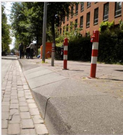
Abbildung 59: Bauliche flexible Barrieren für den motorisierten Individualverkehr im GWL Terrain Amsterdam ermöglichen die Autofreiheit des Quartiersinneren (Quelle: Foletta & Field 2016: 24)
