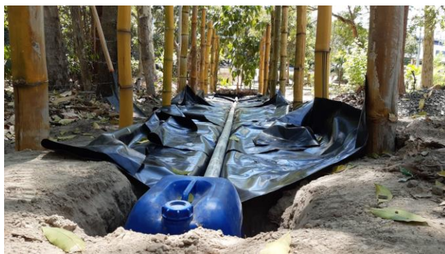
Figura 4. Instalación del sistema de drenaje.
