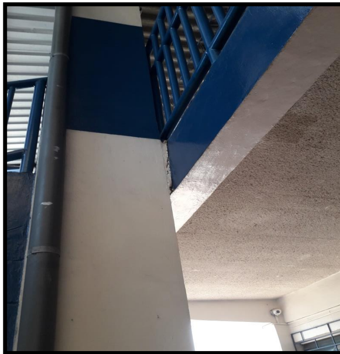
Figura 3. 11 “Columnas del Edificio de Ed. Media a plomo sin presencia de grietas”.
