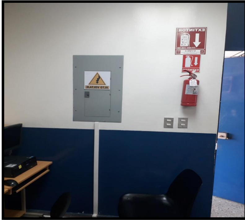
Figura 3. 23 “Señalización de riesgo adecuada de los tableros eléctricos y correctas medidas de seguridad adyacentes a su ubicación”.
