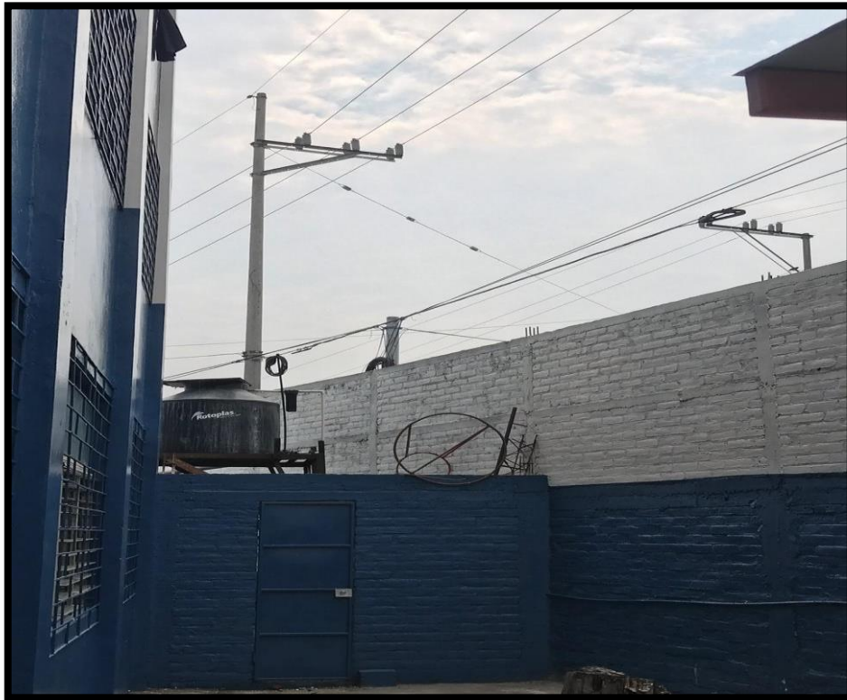
Figura 3. 9 “Depósito de almacenamiento de agua existente”.
