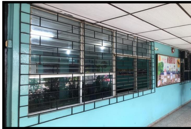
Figura 3. 45 “Condición de las ventanas del sector administrativo”.
