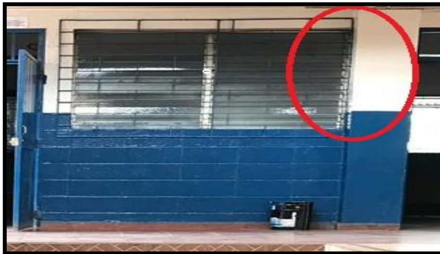
Figura 3. 17 “Columna corta ubicada en una aula del primer nivel”.
