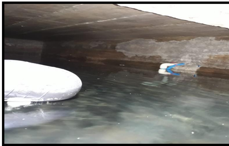
Figura 3. 31 “Interior de la Cisterna”.
