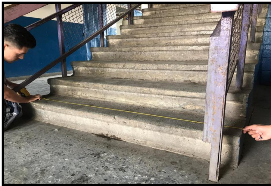
Figura 3. 55 “Medición de ancho de gradas del Edificio de Educación Básica y barandas en buenas condiciones”.
