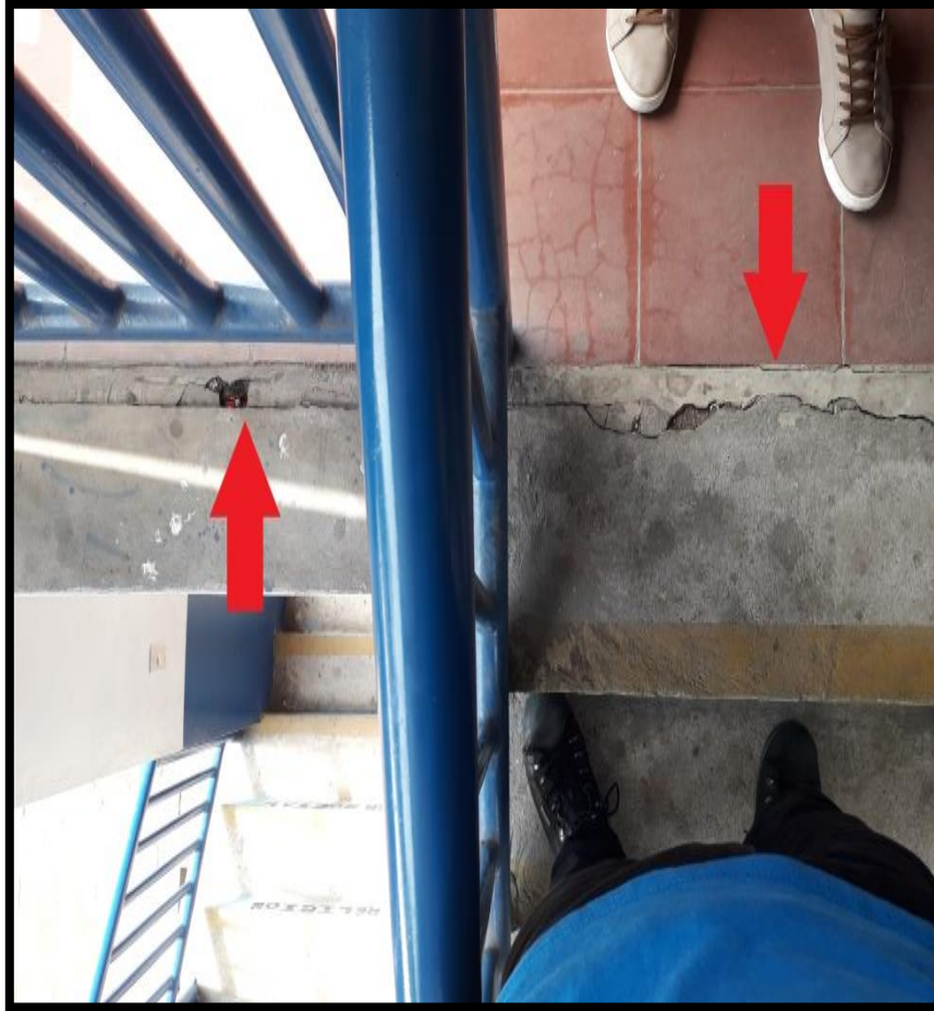
Figura 3. 20 “Existencia de juntas sismicas que aíslan los módulos de gradas del edificio”.
