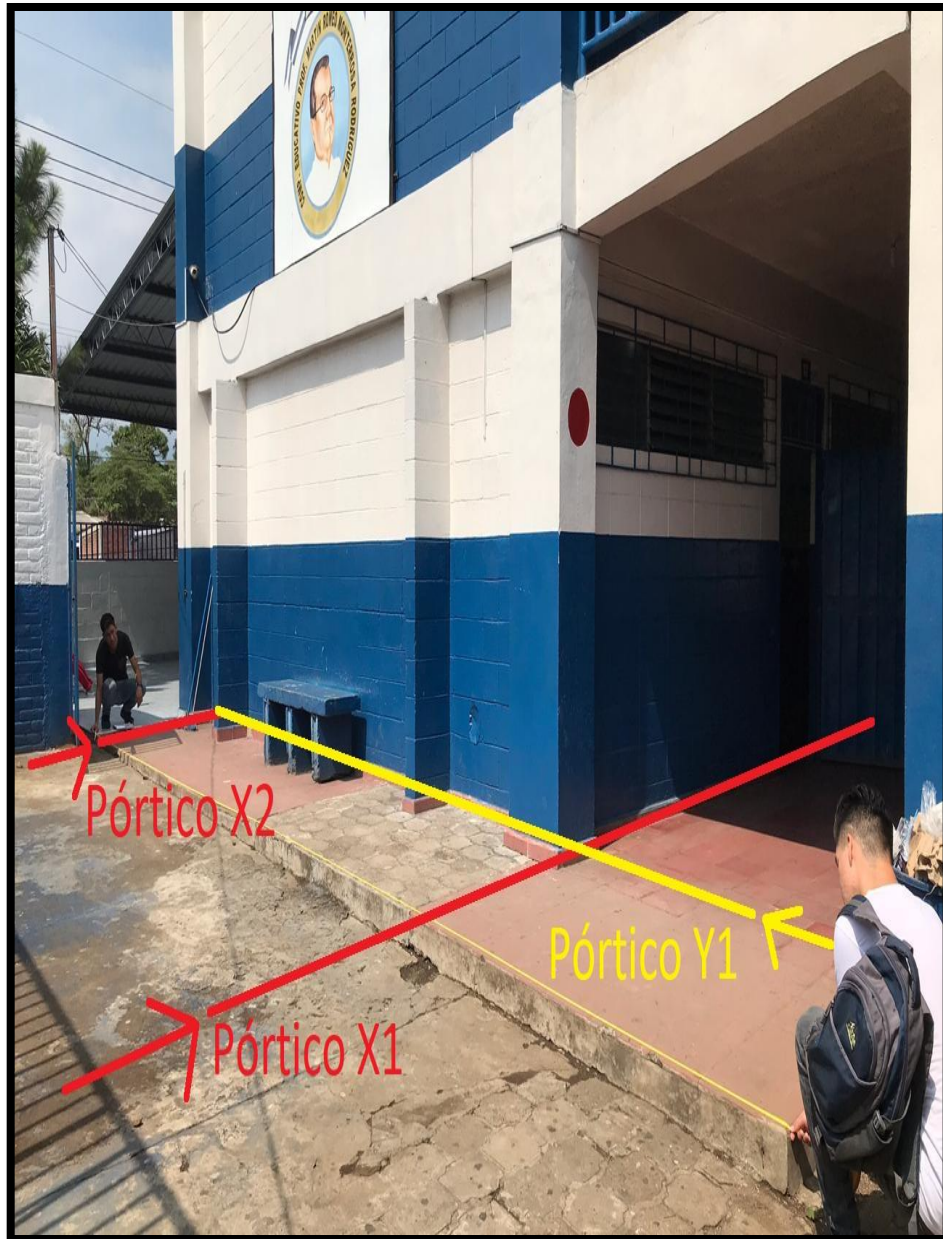
Figura 3. 13 “Medición de dimensiones del Edificio y ubicación de elementos estructurales”.
