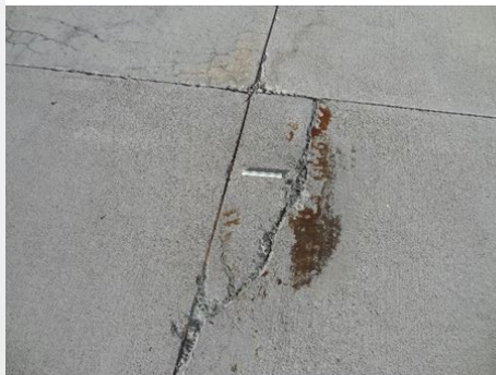
Spalling
