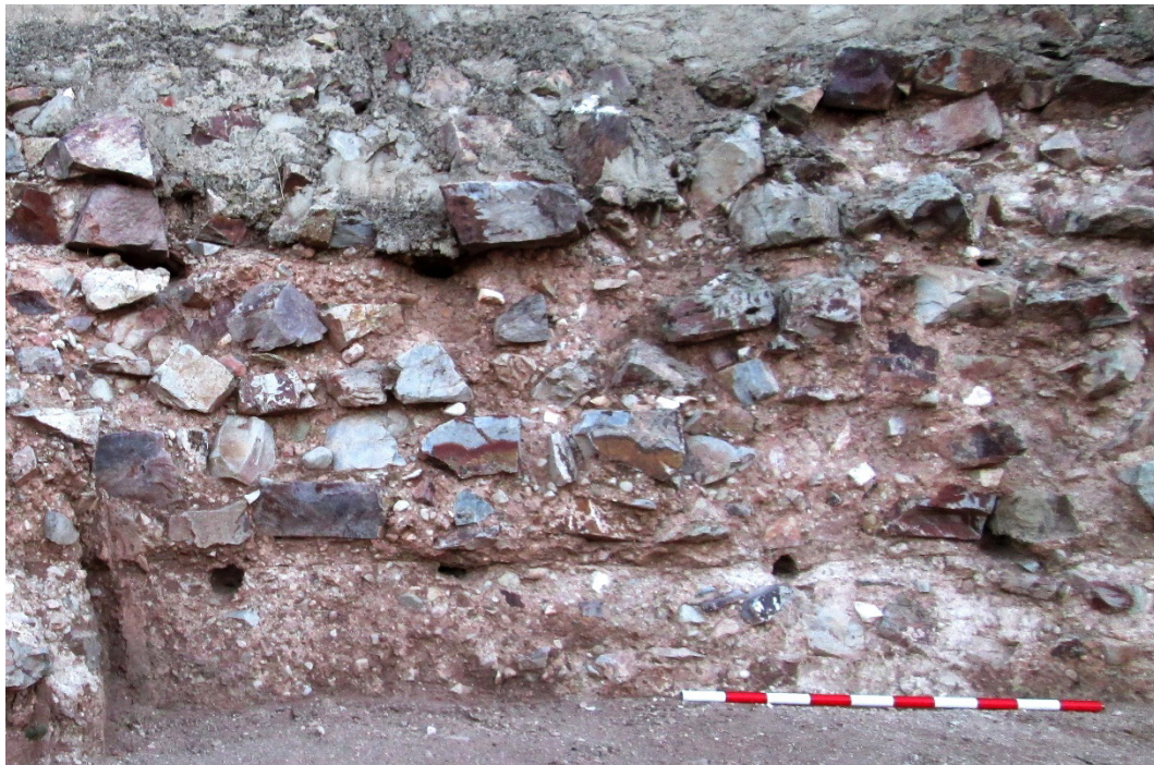
Figura 12. Detalle de junta entre cajones en L-19. Se observan disposiciones superiores e inferiores de los agujales en la junta de unión entre filas de cajones
