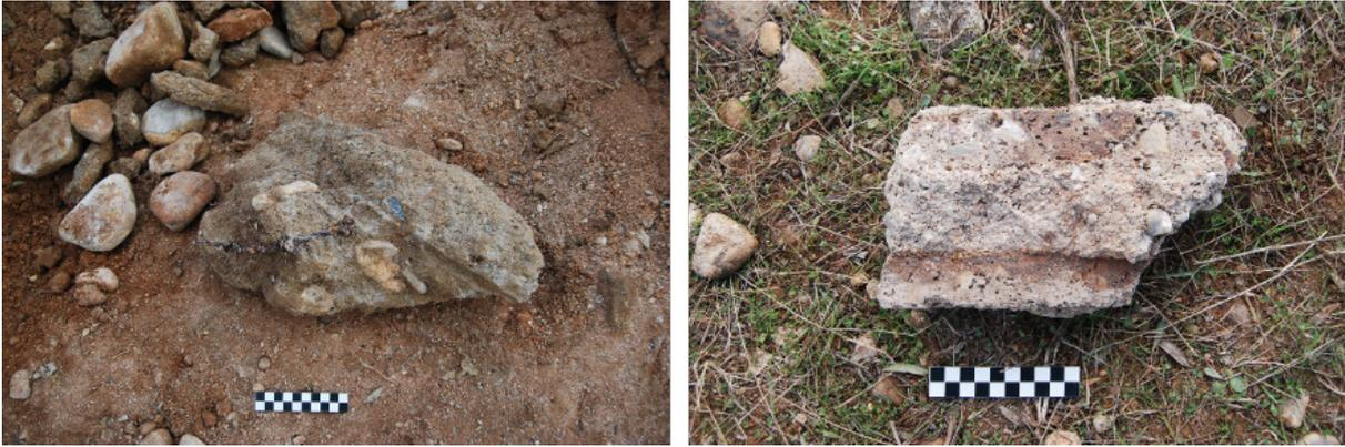
Figura 37. Fragmento de hormigón empleado en el puesto de mando republicano “Las Jariegas” de Azután (Toledo). En las imágenes se aprecia el alambre de espino y los perfiles de hierro utilizados para armar la techumbre de la estructura.
