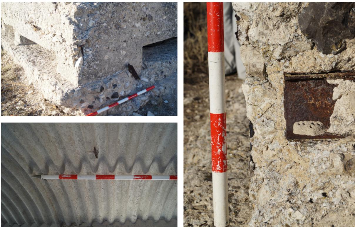
Figura 50. Observatorio franquista nº 2 en el Cerro de San Gregorio, Añover de Tajo (Toledo). Obsérvese los diferentes elementos metálicos que forman parte del armado del hormigón. Arriba a la izquierda una piqueta de alambrada. Abajo a la izquierda ferralla corrugada. A la derecha rail utilizado como cargadero de una tronera.
