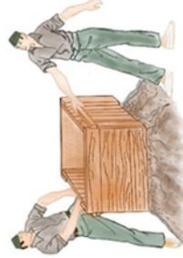
Sistema empleado para medir la mezcla para la elaboración del hormigón. El cajón de madera solía tener unas dimensiones de 50 x 50 cm.
