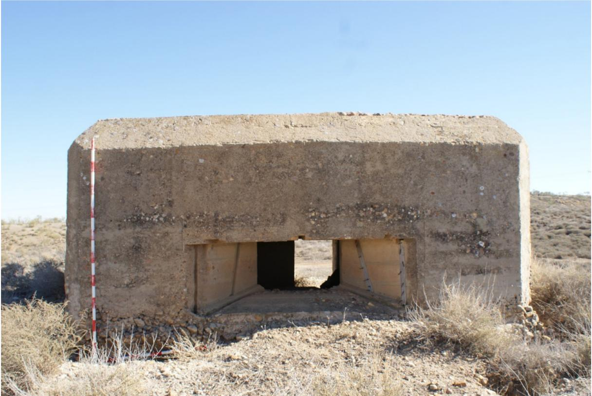
Figura 58. Fortín AZ 26 de El Cerrón, Aranjuez. Sus troneras aún conservan algunos de los listones de madera con clavos, del sistema de blindaje y detención utilizado.
