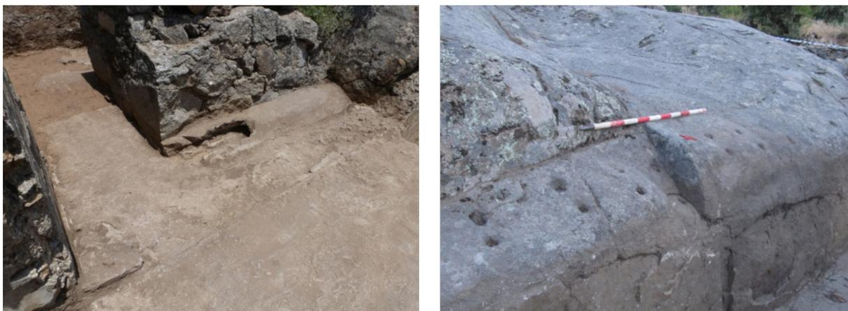
Figura 229. Izquierda: Fotografía de la trinchera junto al acceso al pozo de tirador en la que se aprecia el suelo hormigonado, el canal de drenaje y el muro de refuerzo. Derecha: Detalle de los agujeros realizados en el afloramiento rocoso para, probablemente instalar un elemento de enmascaramiento o de revestimiento de la trinchera.
