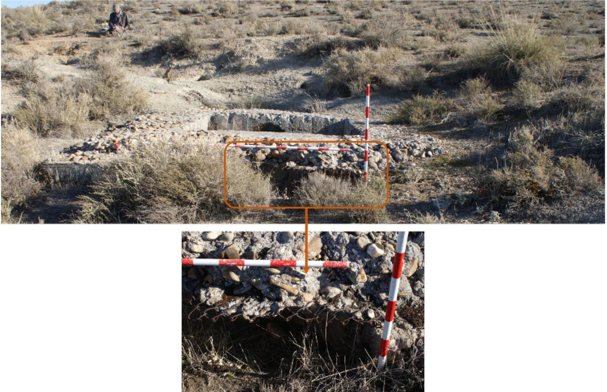
Figura 51. Estructura republicana inventariada con la sigla AZ77. Tipo nido de ametralladora. Localizada en Los Tomillares, Aranjuez (Madrid). Obra inacabada de hormigón armado parcialmente con alambrada.
