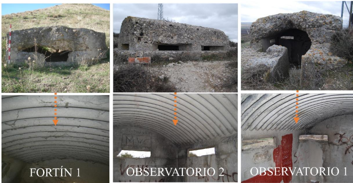
Figura 53. Estructuras documentadas en Añover de Tajo con cubierta realizada con chapa ondulada
