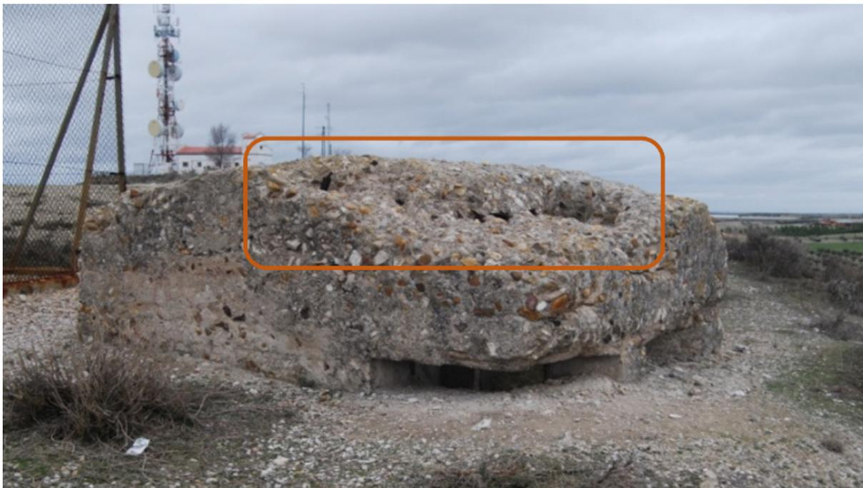
Figura 49. Observatorio franquista nº 1 en el Cerro de San Gregorio, Añover de Tajo (Toledo). Obsérvese la fractura intencionada en el hormigón que deja vista las piquetas de alambrada que conforman la armadura interior.
