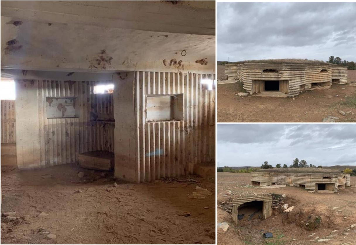
Figura 54. Elemento de fortificación encofrado con chapa ondulada en La Coronada (Badajoz)
