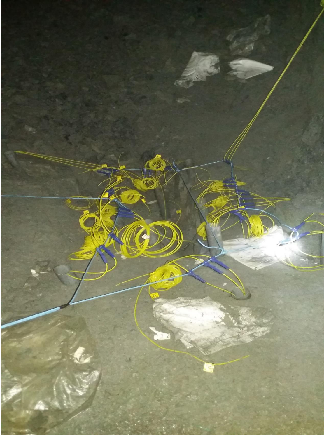
Tomada del área de Operaciones mina - unidad minera Americana
