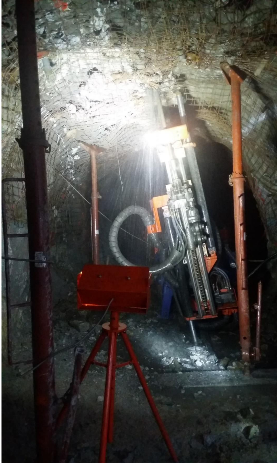
Tomada del área de Operaciones mina - unidad minera Americana
