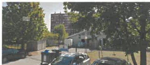
Slika 4.11 Primer prenove vrtec v Dravljah, Ljubljana, Prušnikova ulica.
