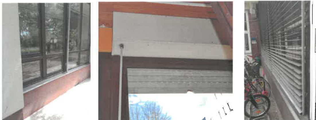
Slika 3.5 Prvotna lesena okna v stavbah predšolske vzgoje v Sloveniji: a) Vrtec v Ljubljani, zgrajen 1981, prvotna lesena okna. b) Vrtec v Mariboru, zgrajen 1978, prvotna lesena okna z roletami. c) Vrtec v Ljubljani, zgrajen 1981, prvotna lesena okna z dodanimi ALU žaluzijami. [Avtor]
