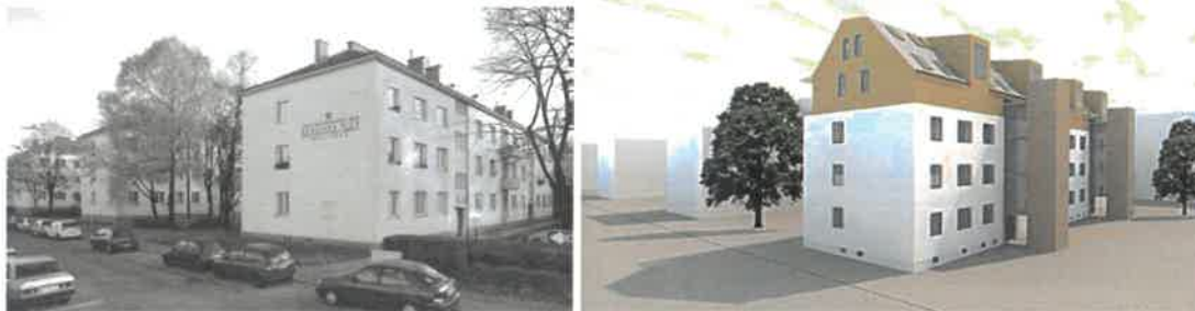
Slika 4.15. Nadgradnja stavbe s prefabriciranimi lesenimi moduli nadgradnje.
