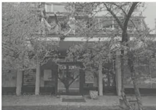
Slika 4.40. Namensko grajena stavba vrtca, v stogom mestnem jedru, Maribor [Avtor]
