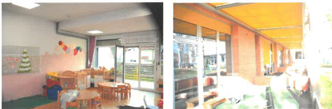
Slika 3.6 PVC in ALU okna v stavbah predšolske vzgoje v Sloveniji: a) Vrtec v Mariboru, zgrajen 1981, prvotna lesena okna zamenjana s PVC okni. b) Vrtec v Mariboru, zgrajen 2012, ALU okna. [Avtor]
