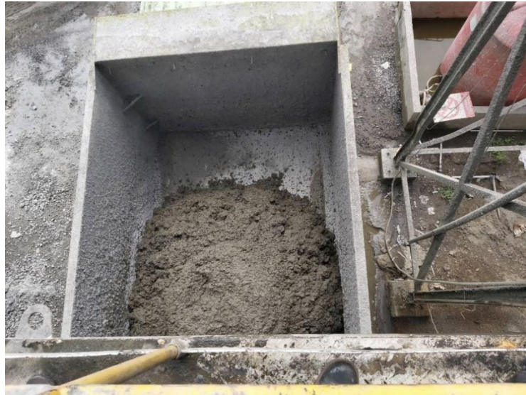
Gambar 2.6 Proses Muat Beton pada Dump Truck
