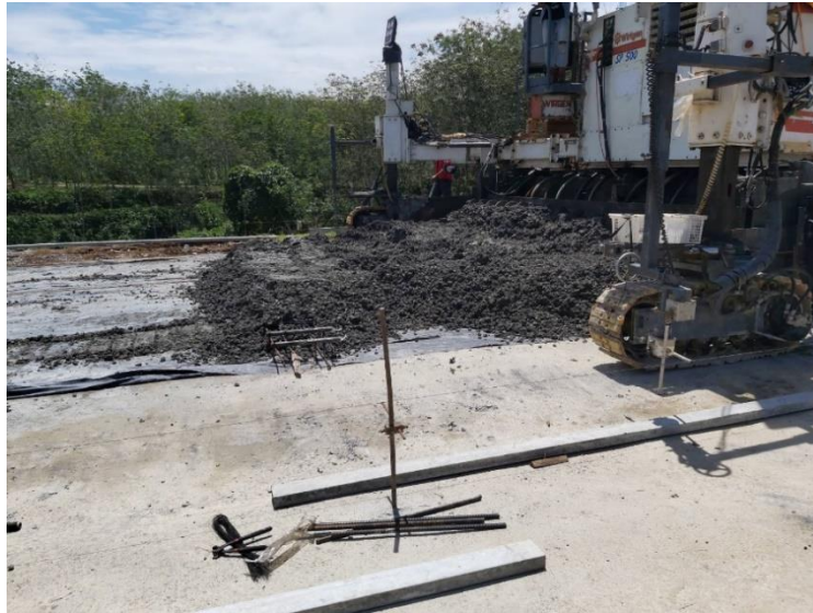
Gambar 2.7 Persiapan Mesin Paver dan Pemasangan String Line
