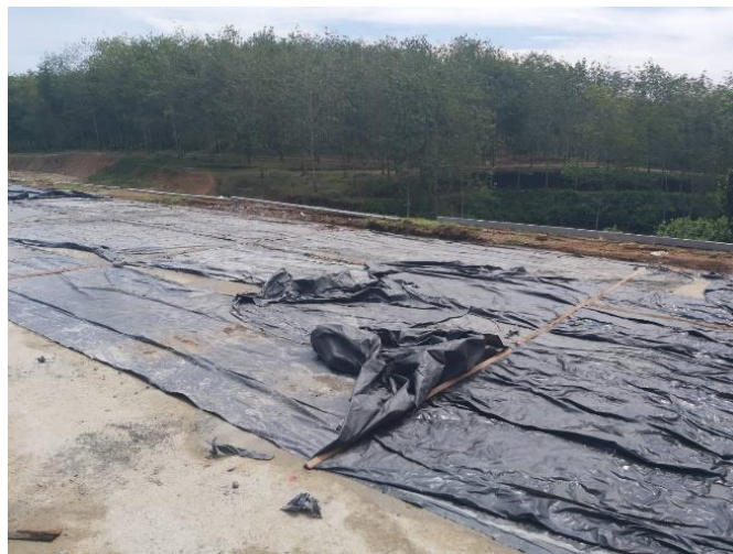
Gambar 2.8 Pemasangan Micron Plastic
