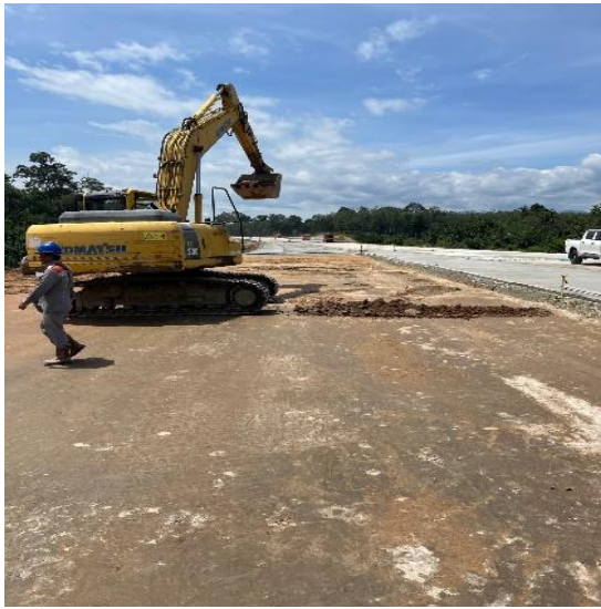
Excavator sedang menggali untuk mengganti tanah di lapangan
