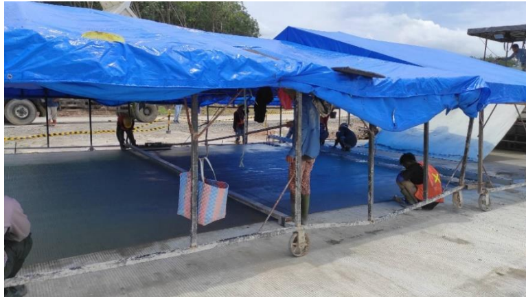
Gambar 2.10 Pekerjaan Finishing dan Grooving Rigid Pavement
