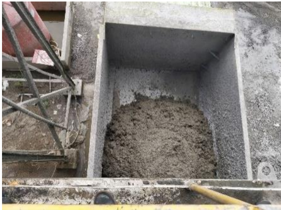
Pemuatan beton siap pakai ke dump truck
