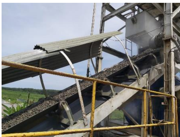
Conveyor belt sedang membawa material pada batching plant
