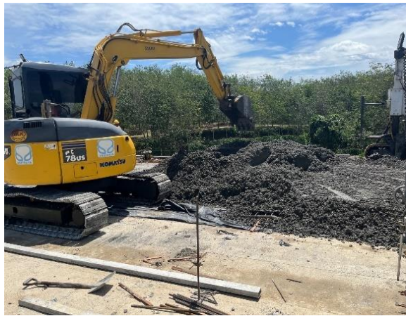
Excavator membantu menghamparkan beton yang dibuang dump truck
