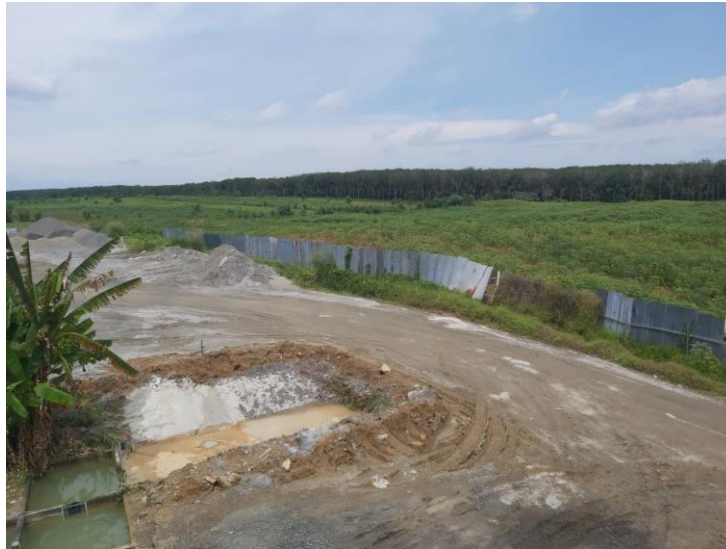
Gambar 2.2 Lokasi Pengambilan Material dari Stock Pile
