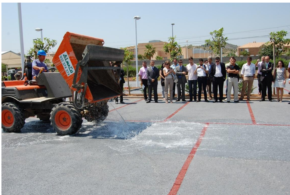
Figura 45. Pavimento permeable en zona de estacionamiento en el municipio de Benaguasil (Valencia).
