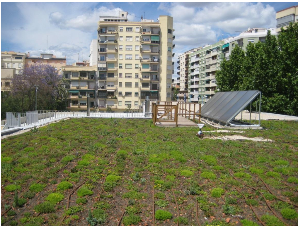
Figura 44. Cubierta vegetada en la azotea del colegio Gonzalbes Vera en el municipio de Xàtiva (Valencia). Proyecto AQUAVAL.
