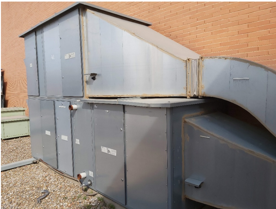
Figura 12. UTA nueva sin utilizar. Imagen propia.
