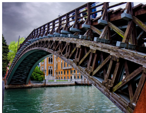
Puente - escalera L'Accademia [23]
