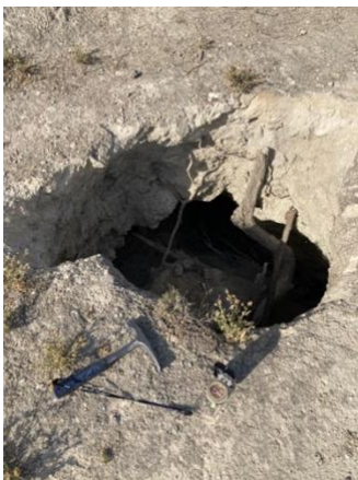
Figura 10. Colapso de pequeña entidad de 1,4 m de eje mayor y más de 4 metros de profundidad. Constituye uno de los colapsos de neoformación y de los que mayor actividad reciente presenta.
