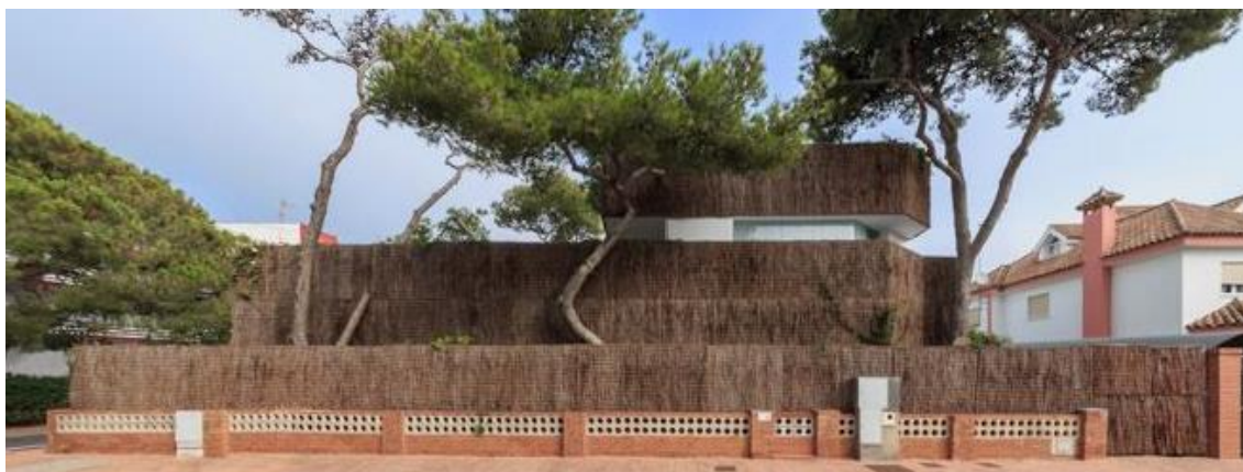
Fig. 25. Vista del muro de la casa desde el exterior
