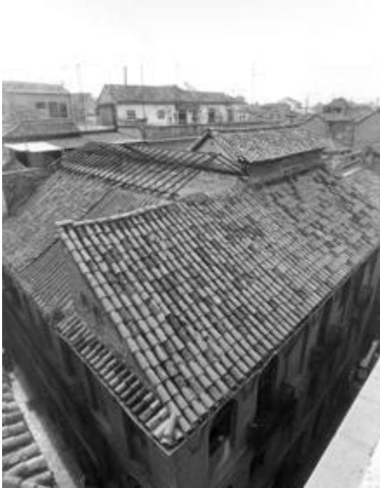
Fig. 8: antes de la intervención
