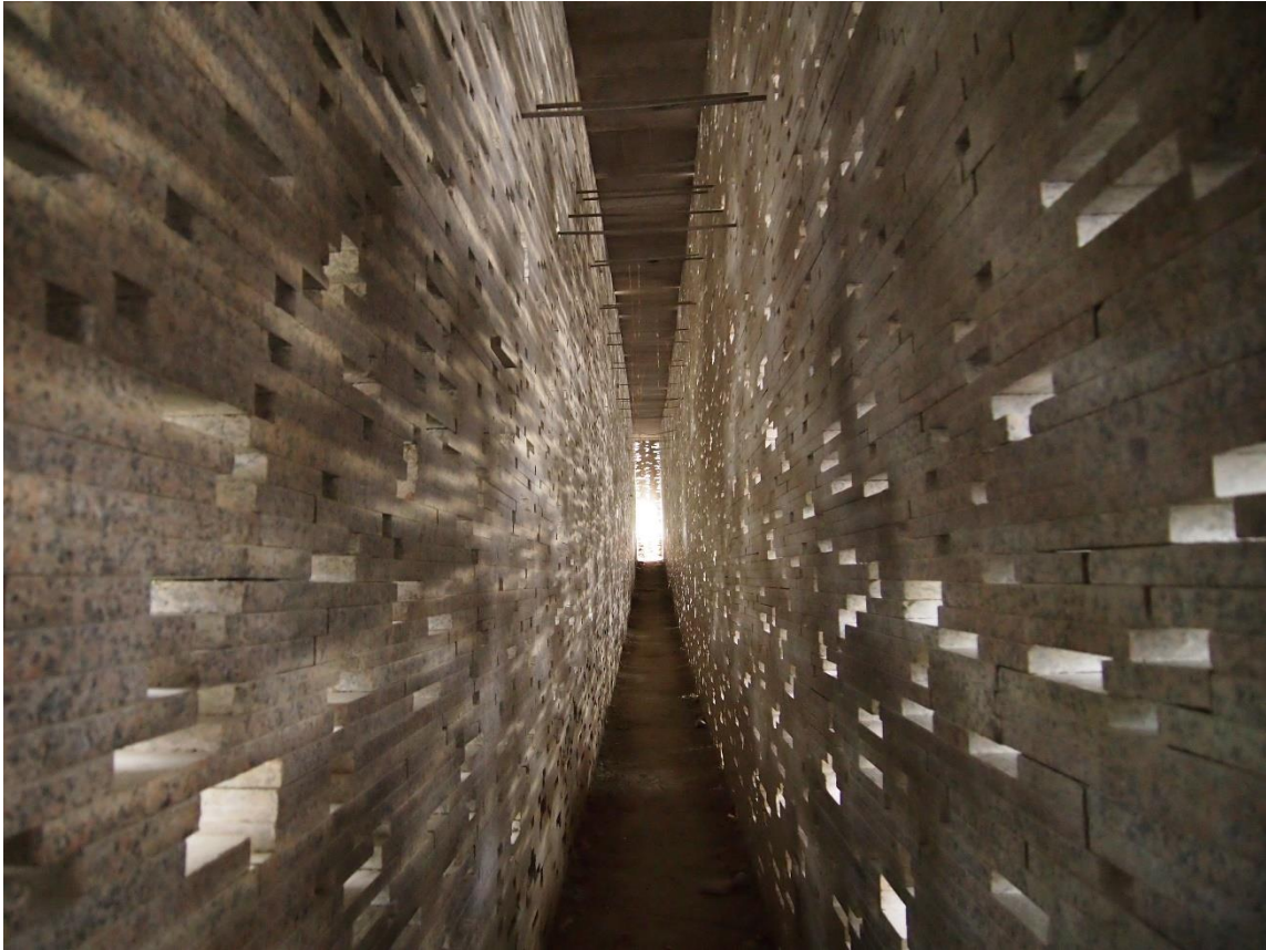
Fig. 15: Interior de la muralla
