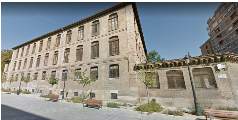
Fachada sur. Fuente: Google Maps.
