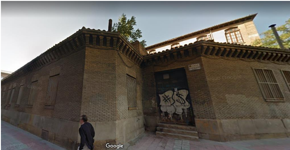
Fachada trasera. Fuente: Google Maps.
