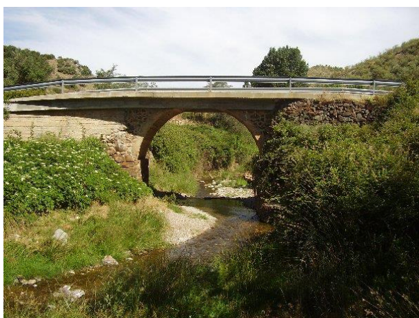
Fig. 124. Puente. Fuente: SIPCA
