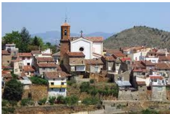
Fig. 119. Iglesia de San Blas. Fuente: Jaime Calatayud.
