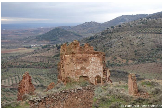
Fig. 72. Convento de San Cristóbal. Fuente: Caminar por caminar.
