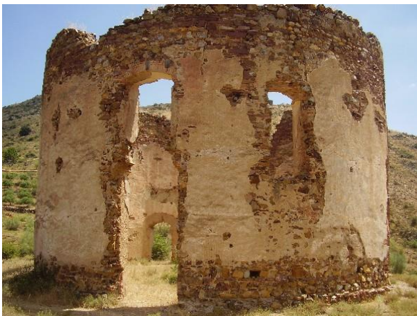
Fig. 71. Baritel de la mina. Fuente: SIPCA
