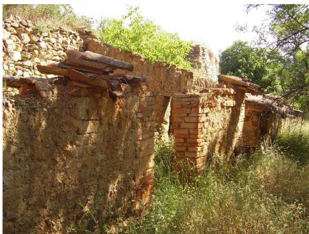
Fig. 126. Fábrica de ladrillos. Fuente: SIPCA
