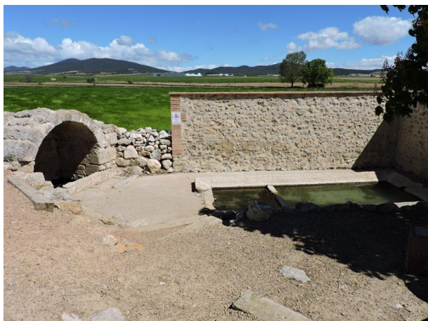
Fig. 118. Fuente y lavadero. Fuente: SIPCA
