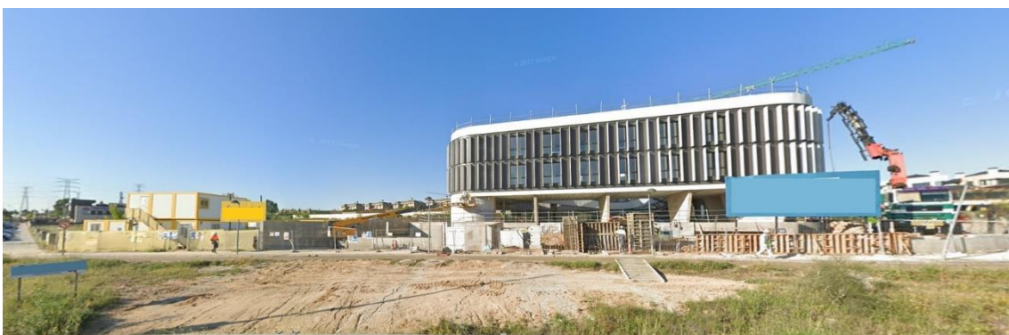
Foto 2: Panorámica de la obra de construcción.
