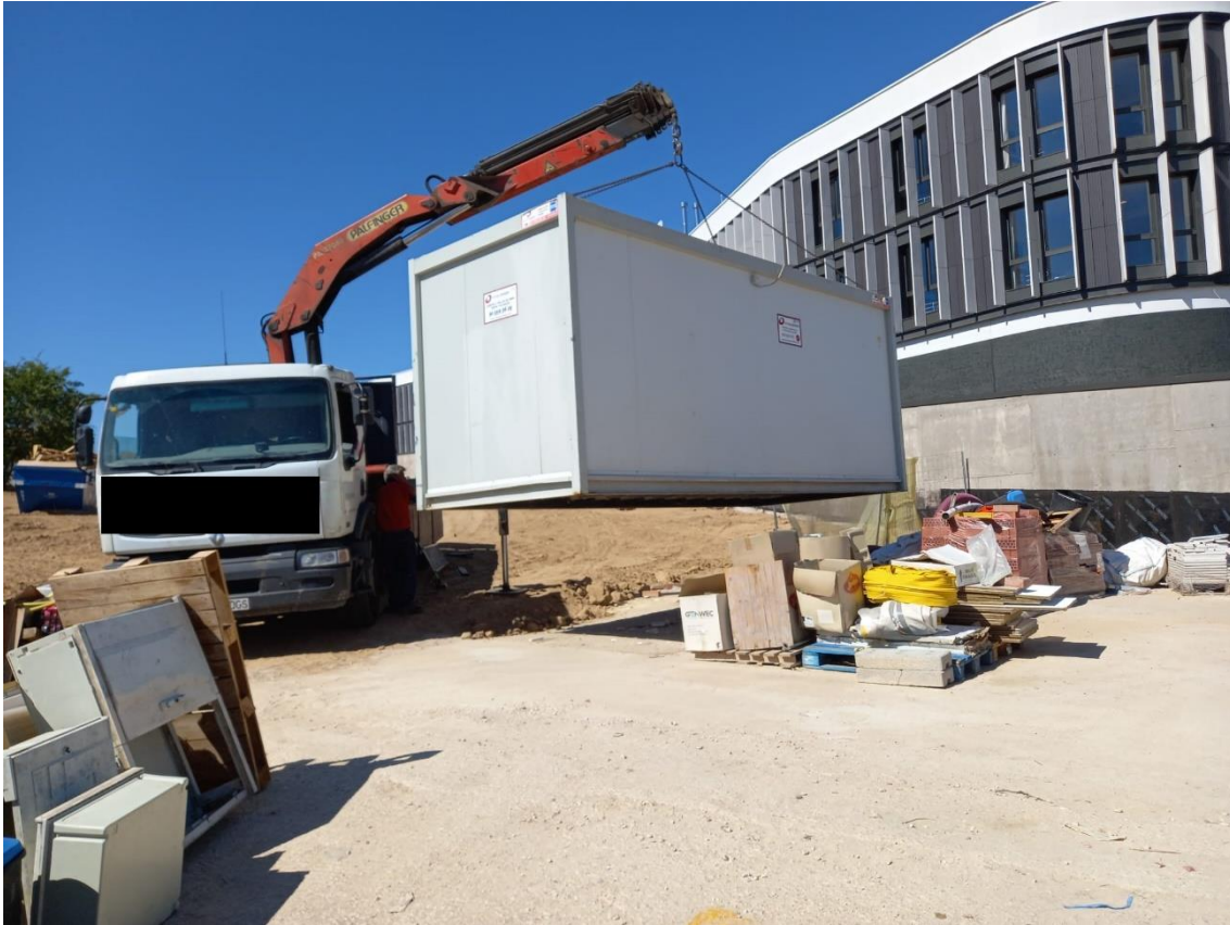
Foto 8: En esta fotografía quería ilustrar como llegó la caseta de obra y donde se instaló para que el lector se pueda hacer una idea de la aplicación real de este plan.
