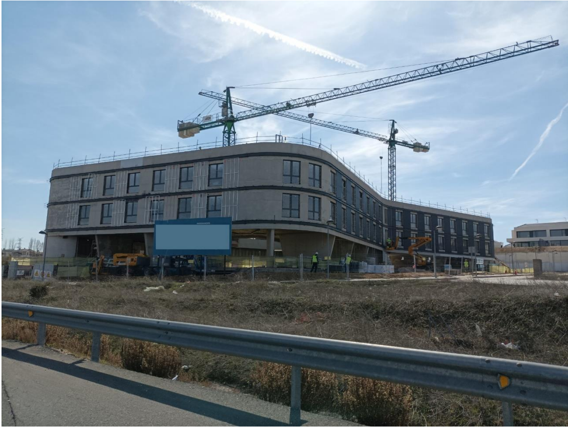
Foto 3: Panorámica de la obra de construcción.
