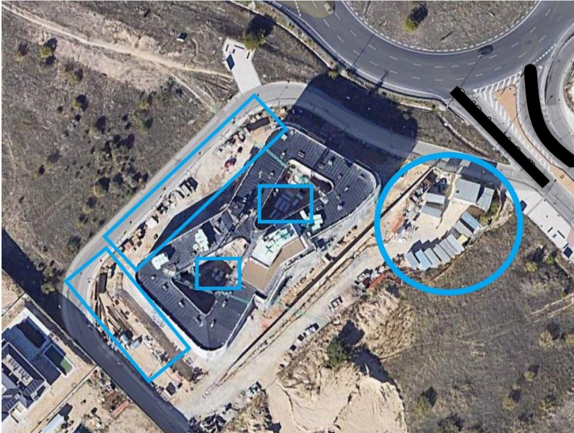
Foto 1: Vista desde arriba de la obra de construcción.
