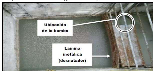
Fig. 4. Ubicación de la bomba y lámina metálica en el homogeneizador.
