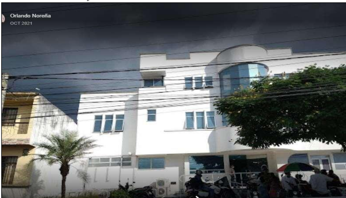
Figura 1 Fachada Clínica San Rafael Sede Cuba-Pereira
