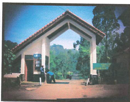
Gambar 4.6. Kondisi jaringan jalan Sumber: Hasil Survey
