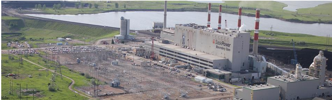
Figura 9. Estación de energía de la presa de frontera.
