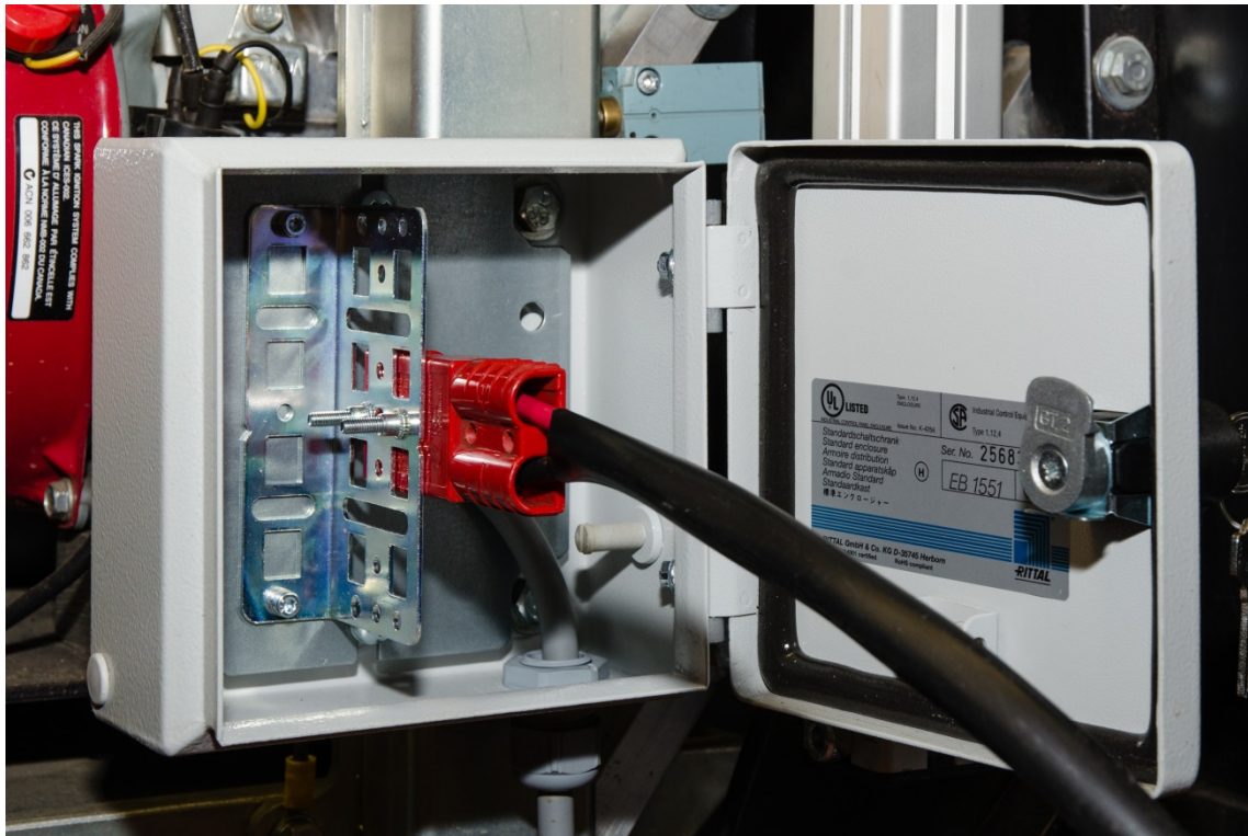
Abb. 59 Anderson SB50 Anschlussstecker mit Ladekabel zum Aufladen der Akkumulatoren.
