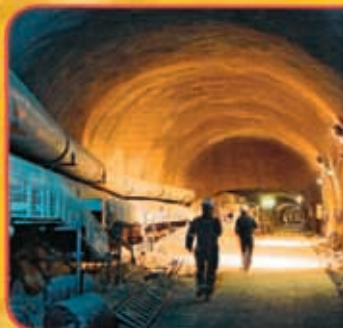
Rohbau: Ehe irgendein Teilchen am LHC kreisen konnte, mussten erst einmal lange Tunnel gegraben werden. In diesen wurde die Beschleunigerrohre verlegt
