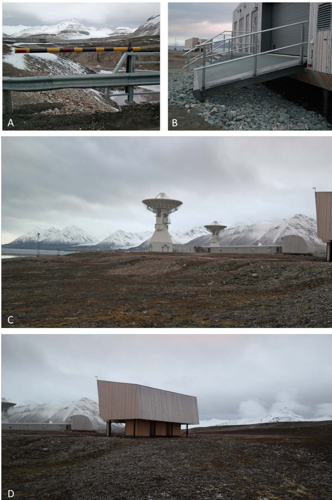
Figur 3.2. A) Bom ved broen over Bayelva. B) Inngangsparti til stasjonsbygget. C) Stasjonsområdet sett fra nordvest. D) Gravimetribygg. Alle bilder fra oktober 2017. Foto: Frode Koppang/Kartverket
