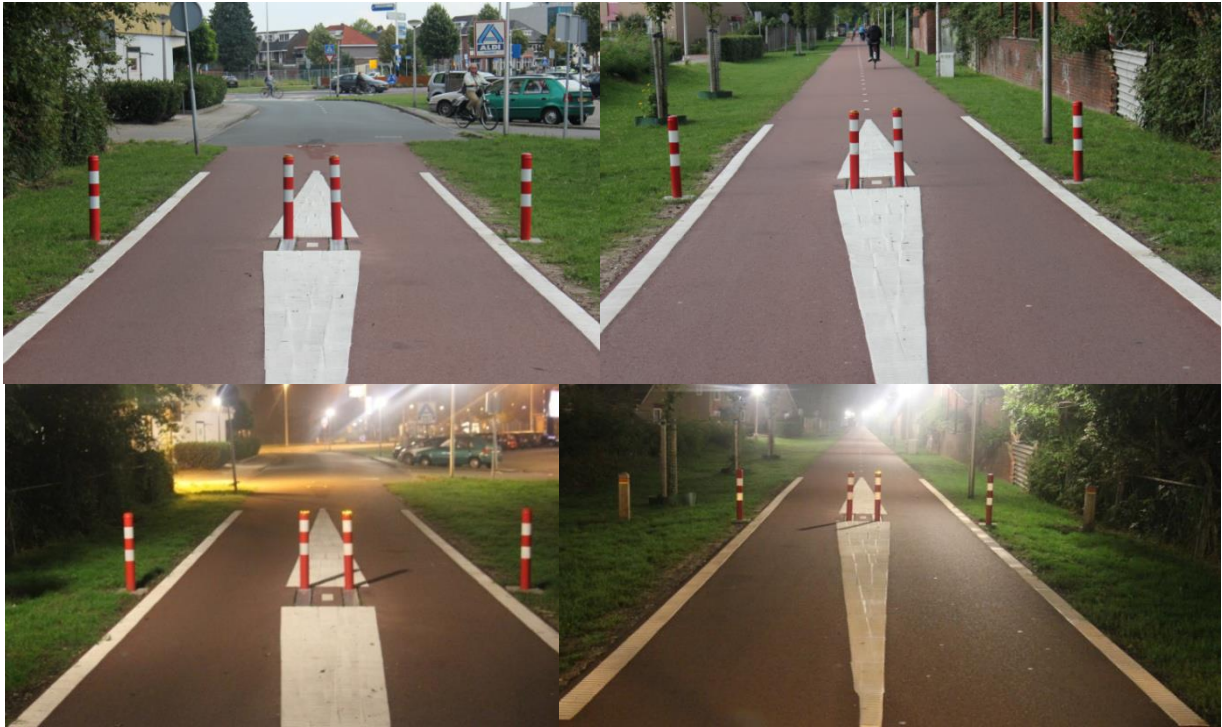
Figuur 27: Foto's van de paaltjes genomen op locatie 4 (Enschede) bij daglicht (boven) en duisternis (onder), zowel naar de kruising toe (links) als van de kruising af (rechts).
