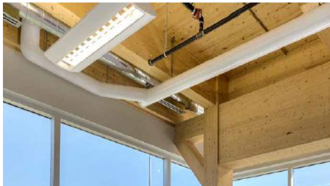
Figure 1.11. Système mécanique suspendu sous un plancher [47].
