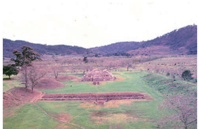
Foto 4. La Estructura 26 y Estructura 31 después de restauración (1995)
