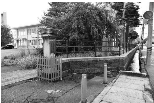
図6 医学類煉瓦塀・門柱 現況写真
