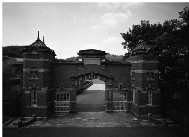
写真13 金沢監獄正門
