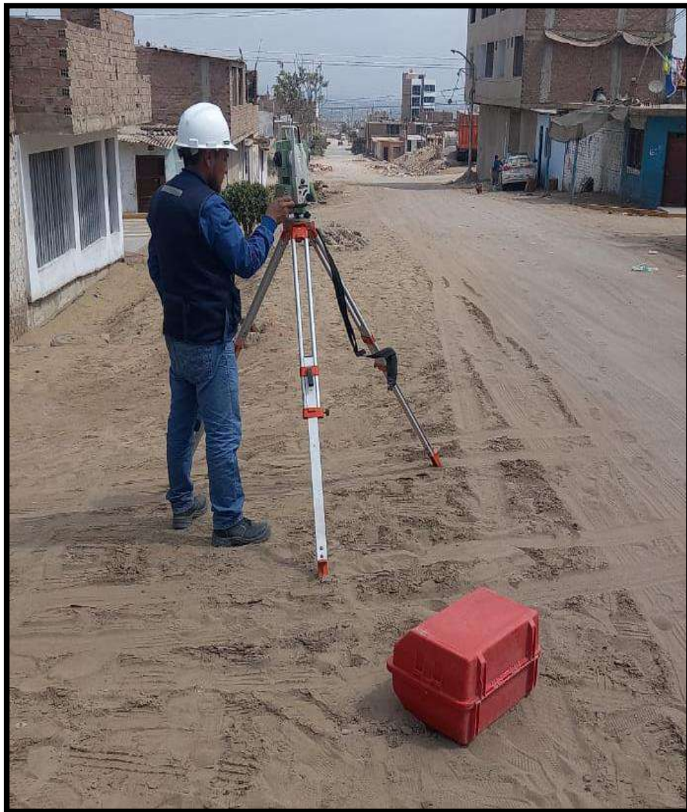
Anexo 3.10: Lectura de puntos con estación total pared de vivienda.
