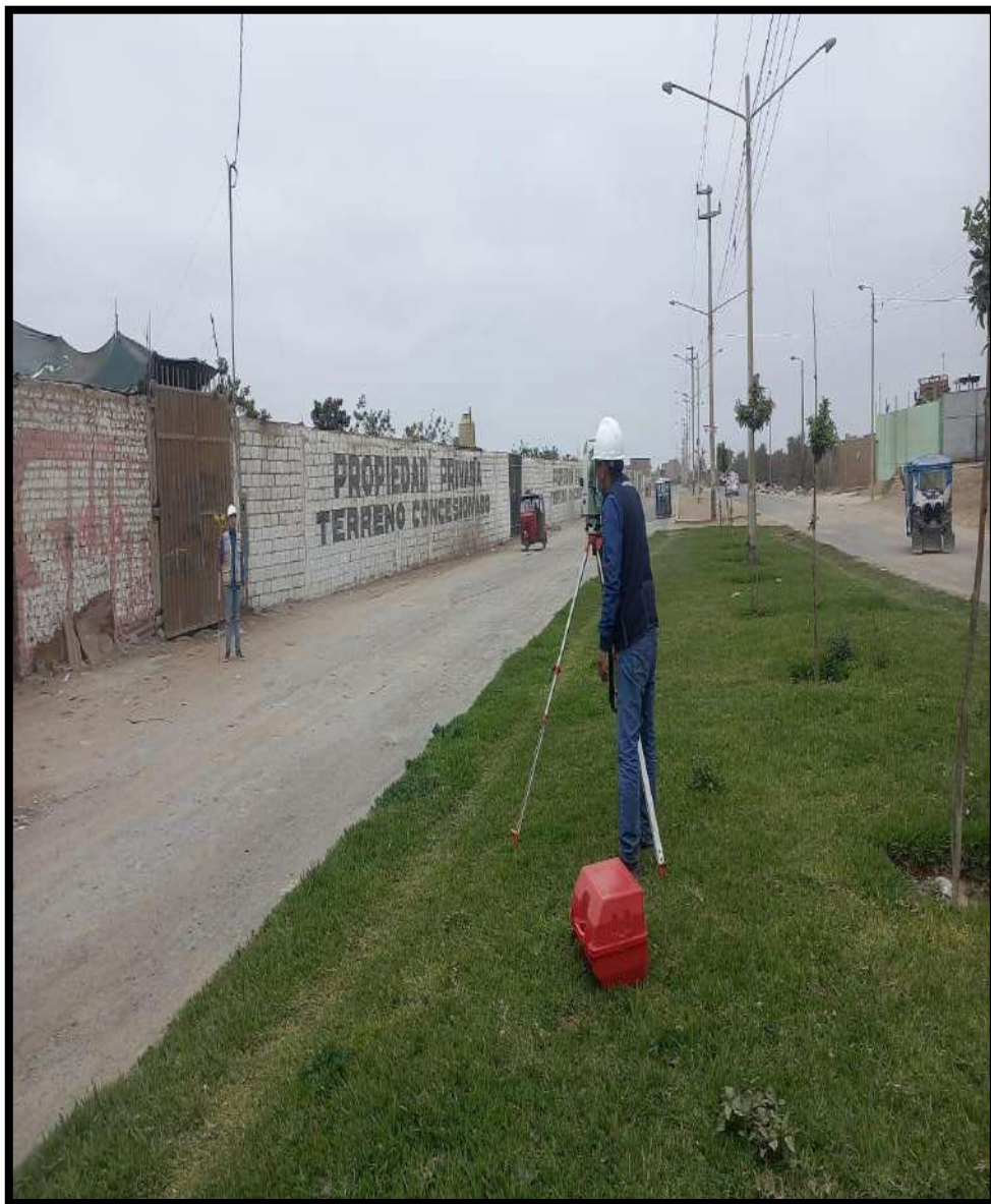
Anexo 3.4: Lectura de puntos con estación total calzada derecha.
