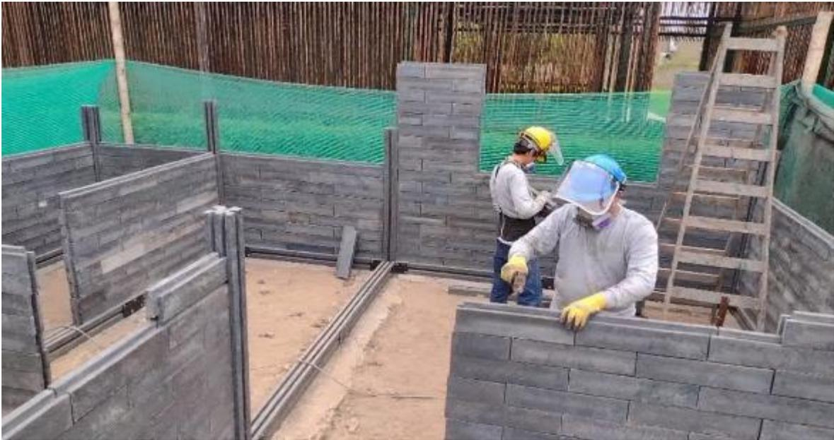
Nota: En esta presente figura se aprecia la construcción de una vivienda con ladrillos de plásticos con materiales reciclados. Fuente: <https://munisurco.com>.
