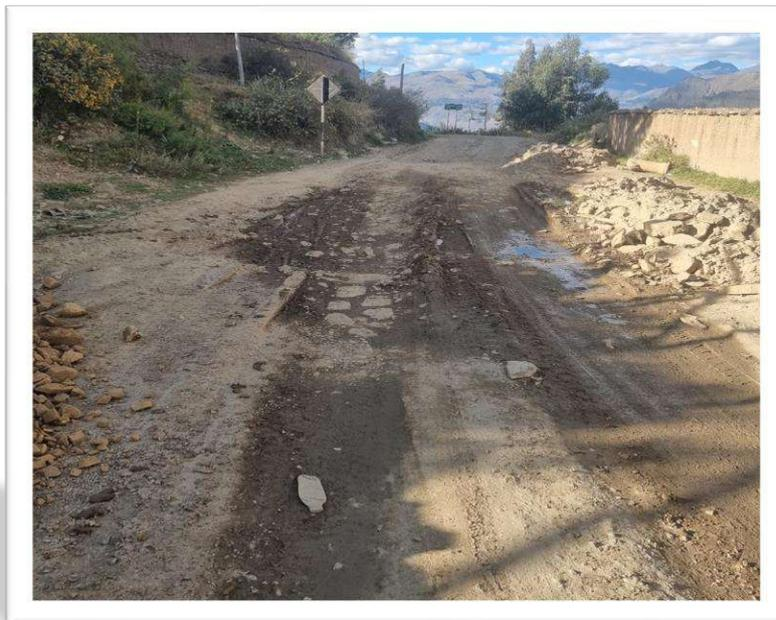
**Imagen 04.-** Se aprecia hundimiento y la pérdida total de la carpeta asfáltica por la constante humedad debido a las aguas pluviales en la progresiva del KM 92+000.00 de Pallasca.
