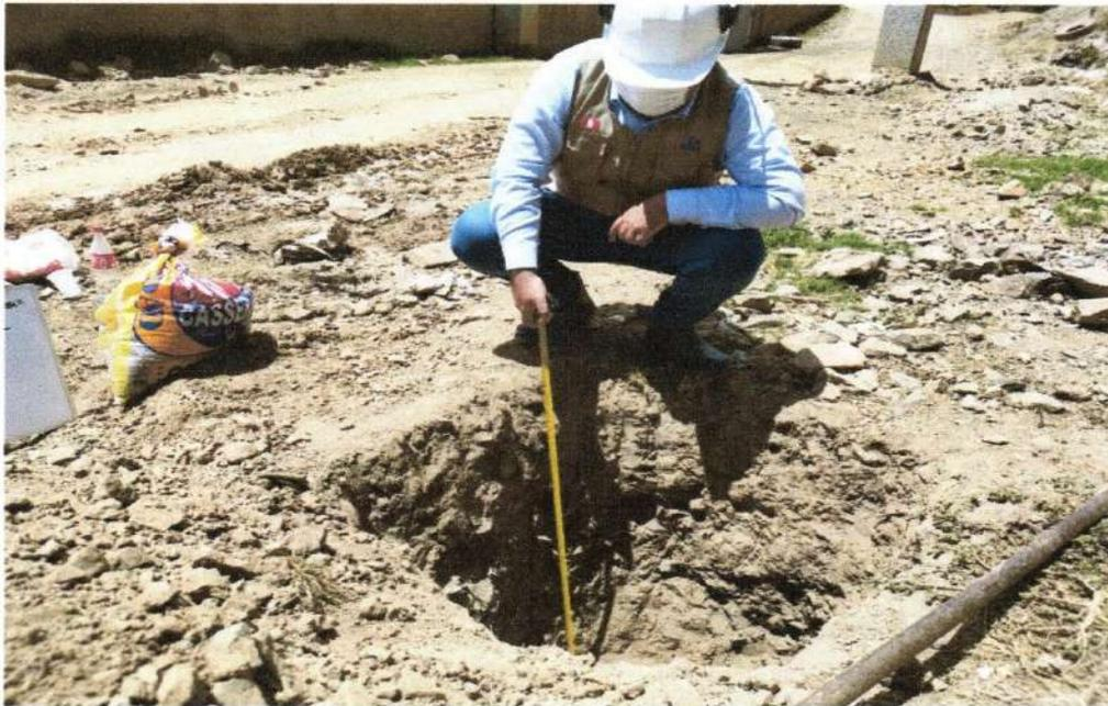
FOTO N°04: EXCAVACION DE LA CALICATA C-02
