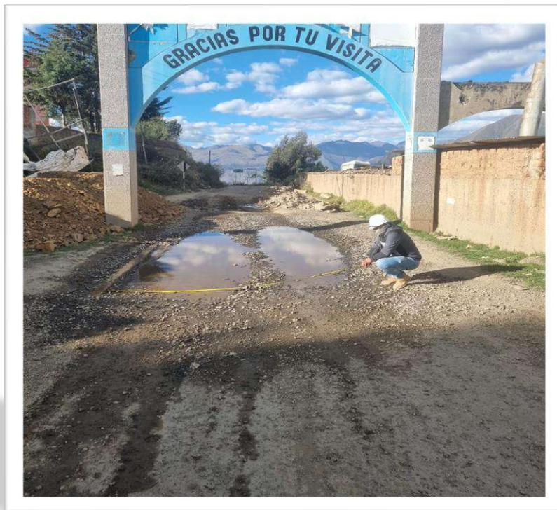
**Imagen 02.-** Se toma las medidas de la parte afectada de la carpeta asfáltica
