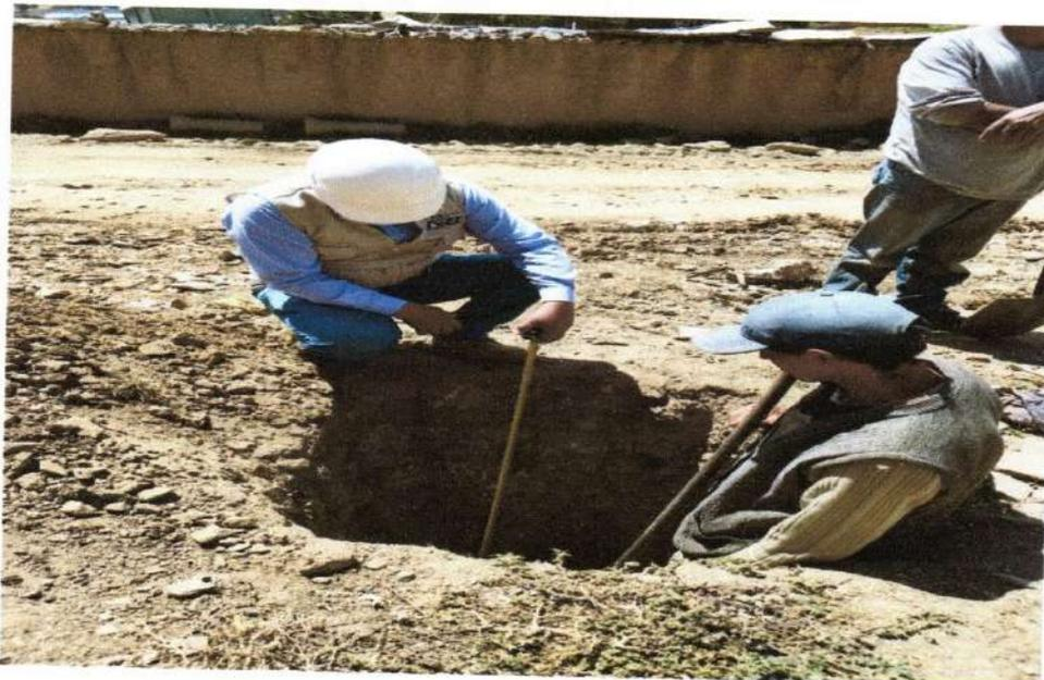
FOTO N°02: EXCAVACION DE LA CALICATA C-01
