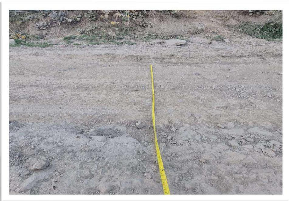
**Imagen 06.-** Se aprecia en el deterioro de la carpeta asfáltica en todo el ancho de la carpeta de rodadura.
